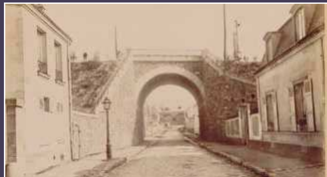
Vue du viaduc de la Petite Ceinture publiée par Albert Broise, Syndicat du chemin de fer de ceinture de Paris. Suppression des passages à niveau, 1887-1889 (© BnF / Gallica).
