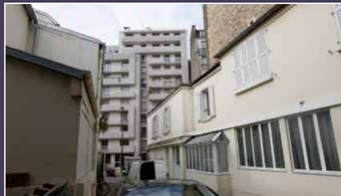
Vue sur la cour, 2024 (© DHAAP / PS).
