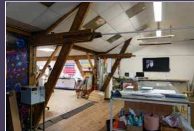
Vue des structures bois du hangar, 2024 (© DHAAP / PS).
