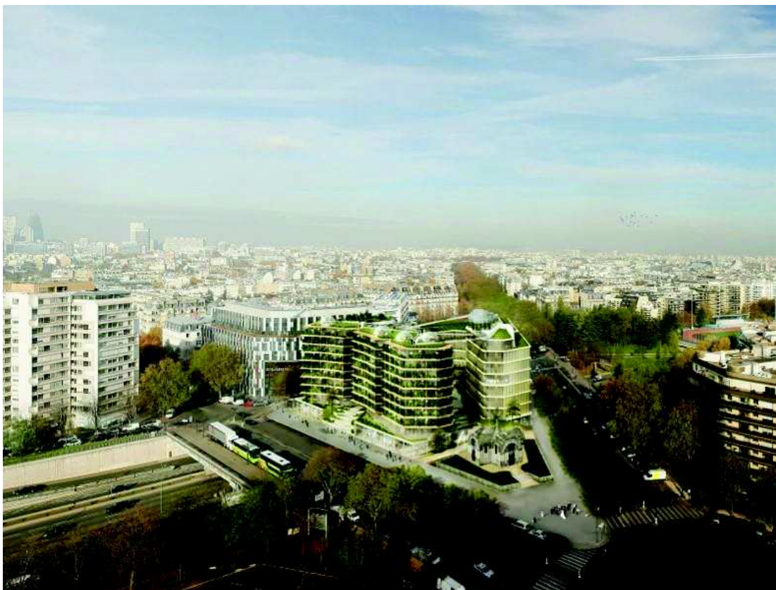
La ville multi strates - Architecte Jacques Ferrier
