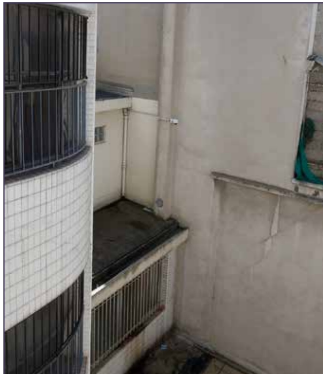
Vue actuelle de la cour et des façades sur cour.
