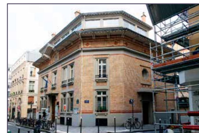
Vue de l'école depuis la rue Beauregard.
