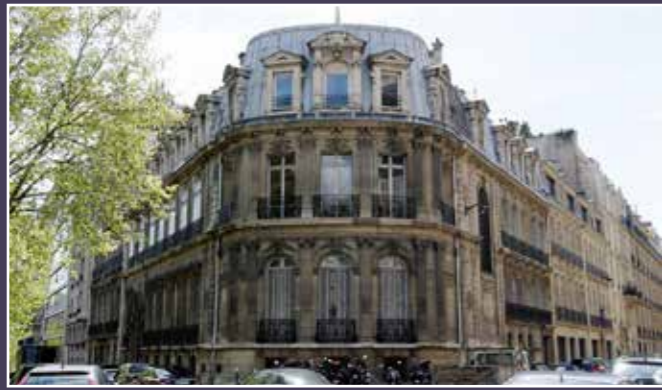
Vue depuis l'angle des deux voies (2012).
