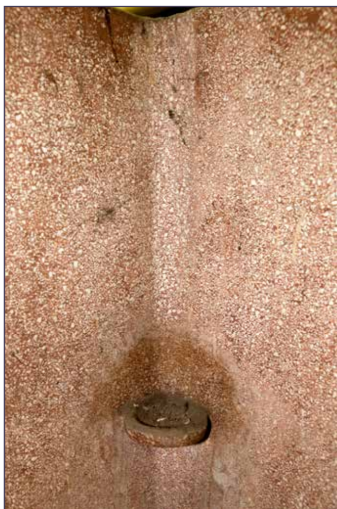
Détail des cloisons en granito et du porte-savon.
