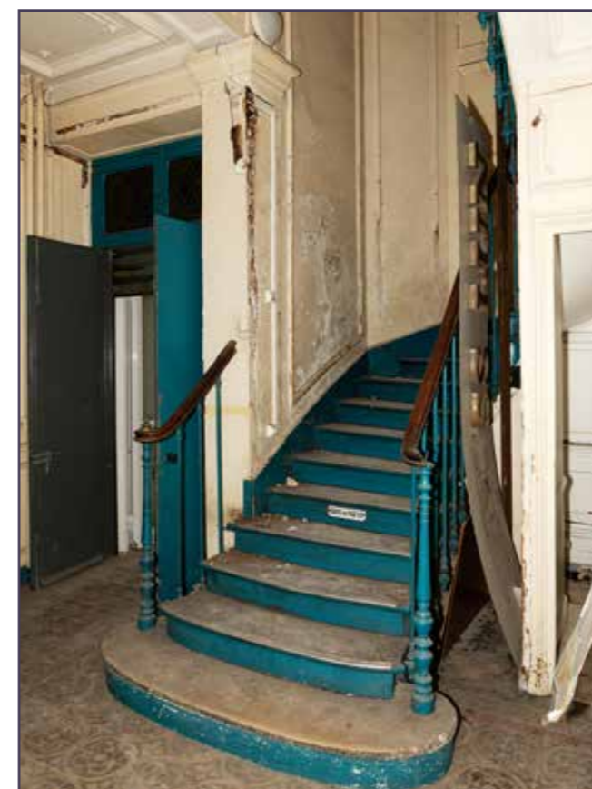
Vue actuelle de l'escalier principal.
