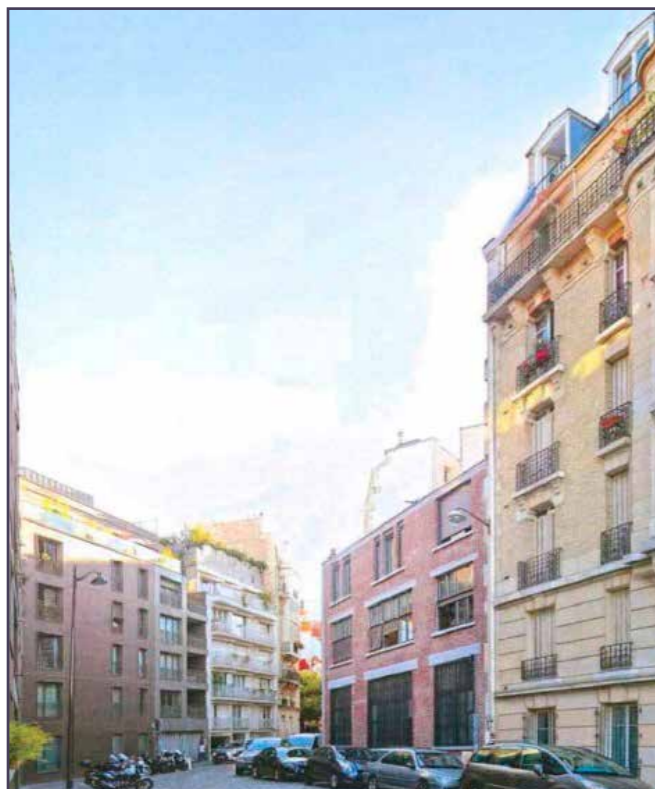
Vue actuelle du bâtiment (© Axel Schoenert architectes).
