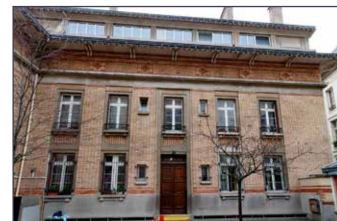
Vue de la façade arrière du bâtiment sous lequel se situent les douches scolaires.
