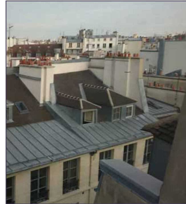
Vue actuelle de la toiture (© Atelier d'Architecture - Frédérique Brizzi Pellotier
