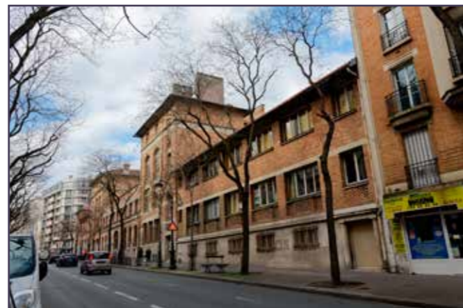
Façade sur rue de l'école. À droite, la porte condamnée.
