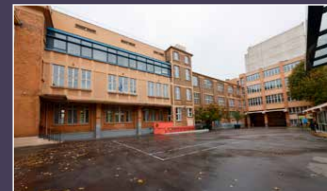
Vue actuelle du revers du bâtiment principal depuis la cour.
