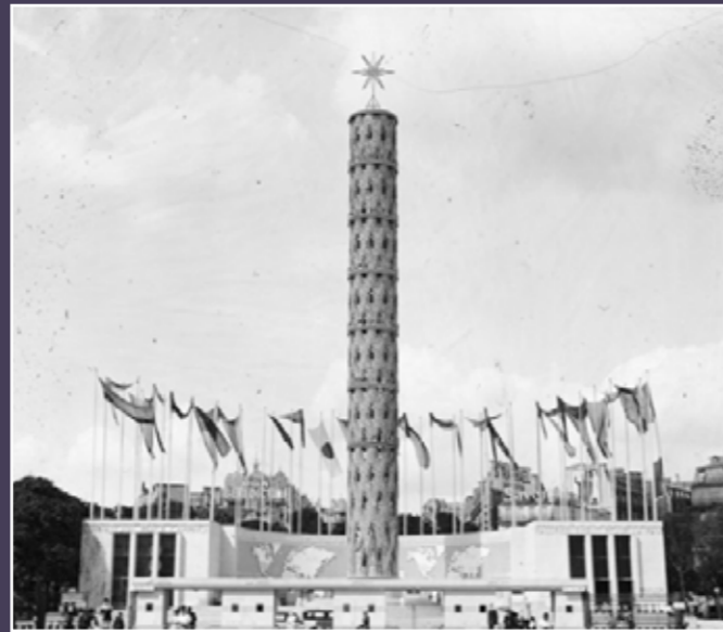
Vue de la Colonne de la paix édifée place du Trocadéro, 1937 (© Documentation OnEi).
