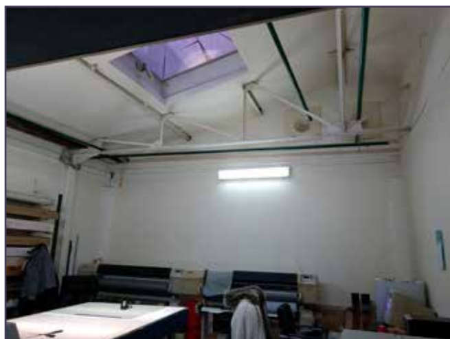
Locaux sous l'ancienne verrière dans la cour.
