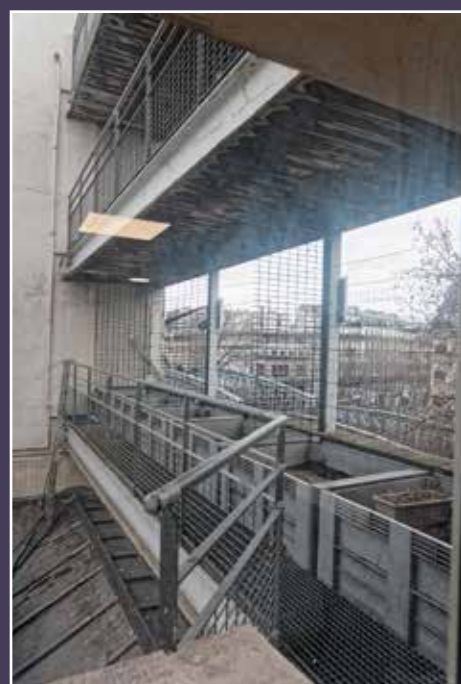
Vues de la passerelle et du jardin suspendu.
