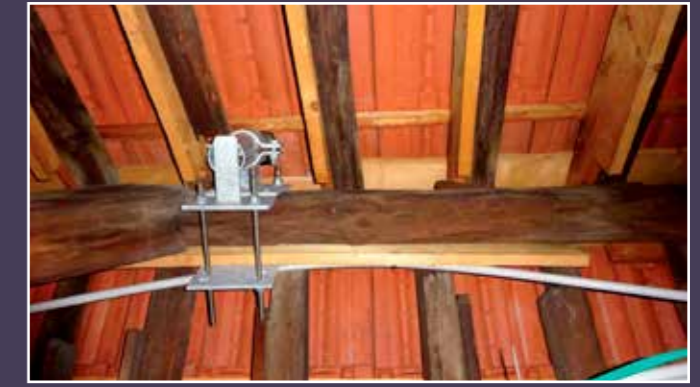
Vue actuelle de la charpente (© GRAHAL).
