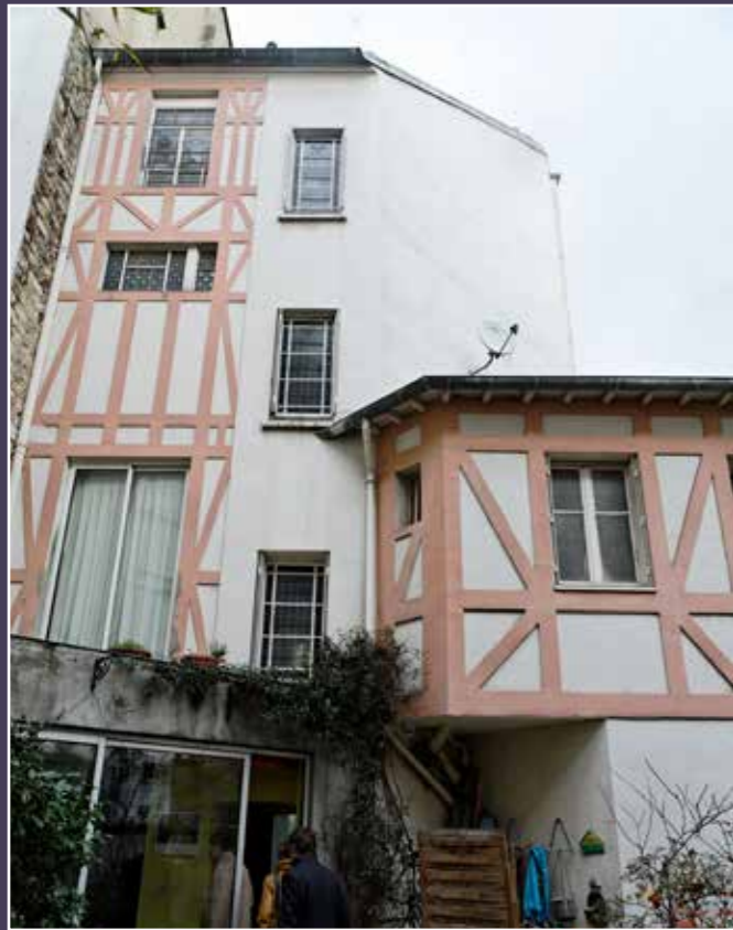
Vue des façades côté cour.
