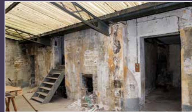
Vue de la façade en rez-de-chaussée de la maison.
