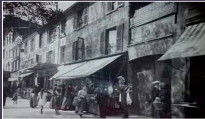
Vue du 26-28, avenue d'Orléans en mai 1914 (© BHVP / Grahal).
