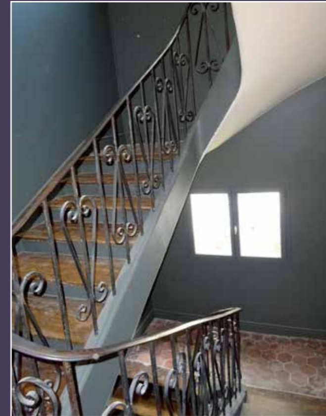
Vue actuelle de l'escalier (© GRAHAL).
