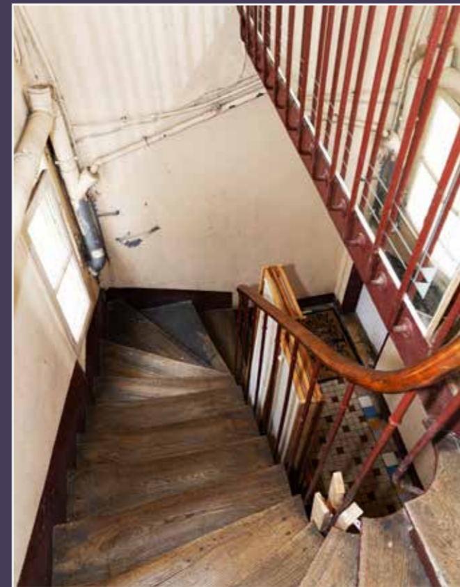
Vue actuelle de l'escalier.
