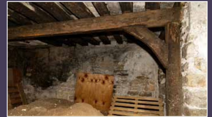
Vue de la salle semi-enterrée.
