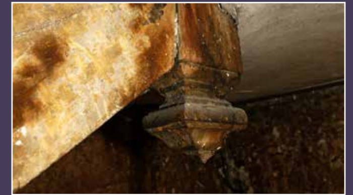
Détail de l'escalier.
