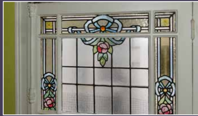
Détail d'une fenêtre de l'escalier.
