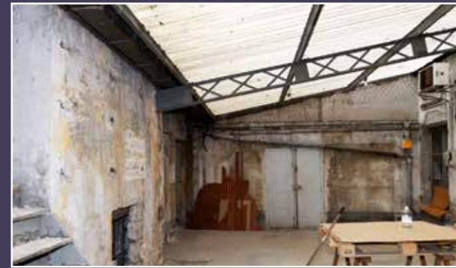
Vue de la cour couverte reliant le bâtiment sur rue et le bâtiment sur cour.
