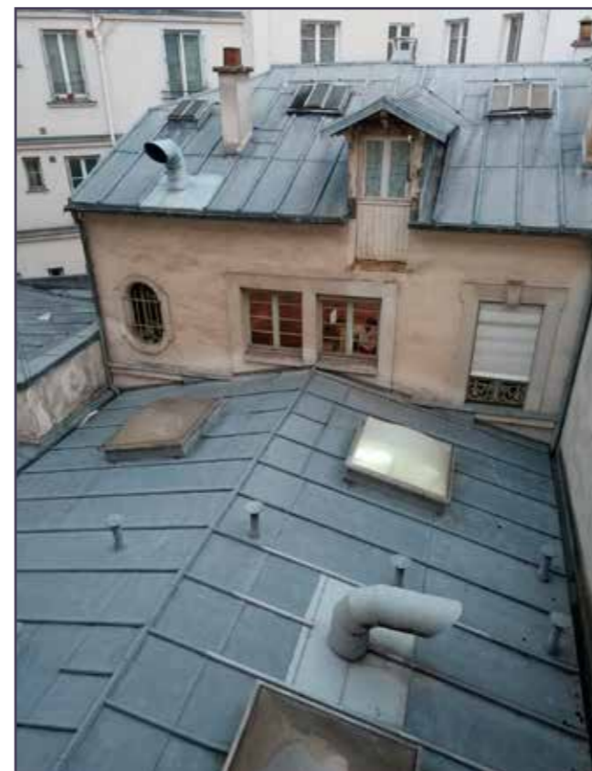
Couverture de la cour et bâtiment de fond de parcelle.
