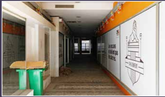
Vue de la galerie commerciale des Portiques d'Orléans.
