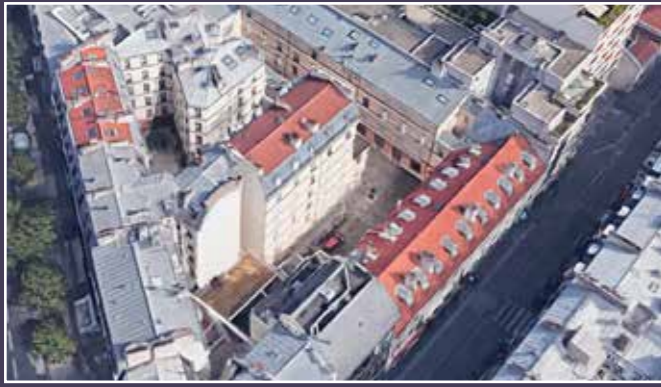
Vue aérienne de la parcelle.
