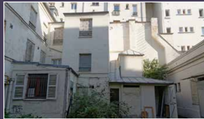
Vue des bâtiments dont la démolition est demandée.
