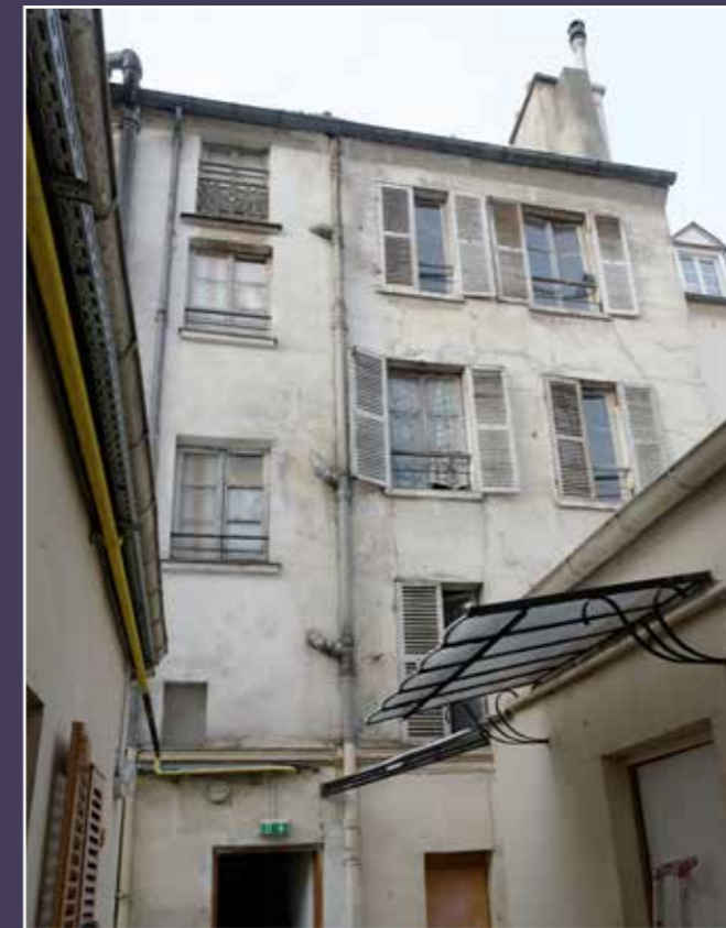
Vue actuelle de la façade arrière de l'immeuble sur rue.
