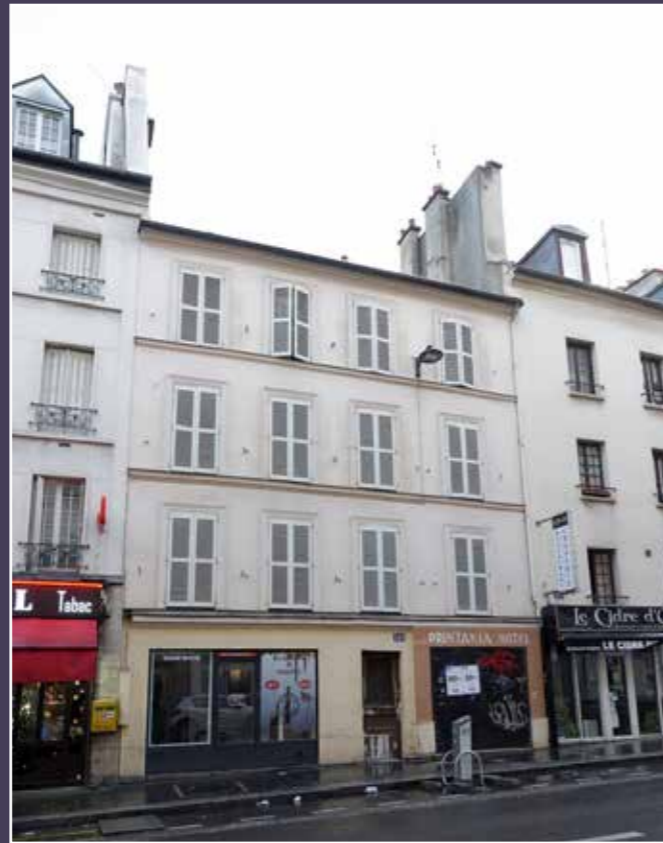
Vue actuelle de la façade principale du bâtiment sur rue.
