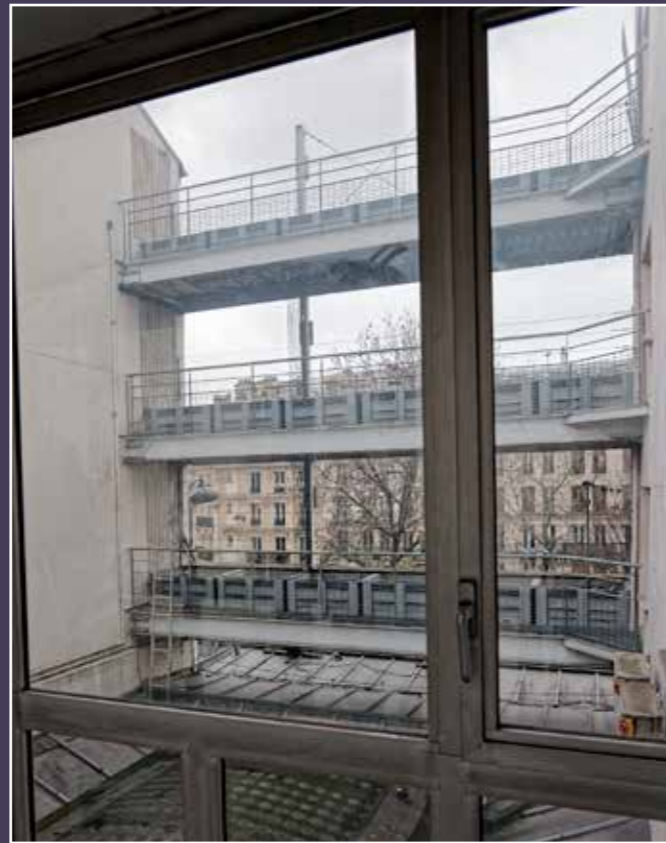
Vue de la dent creuse et de la dalle de verre depuis le fond de parcelle.
