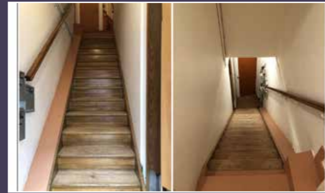
Vues actuelles de l'escalier de l'entrée (© Global Architecture).
