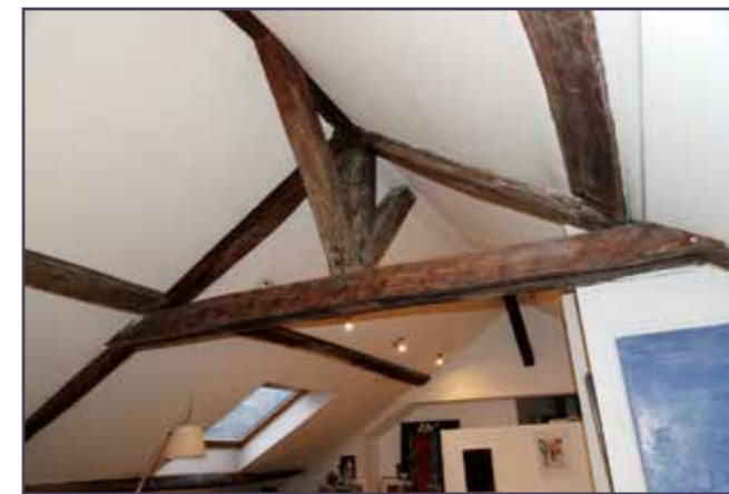
Vue de la charpente.
