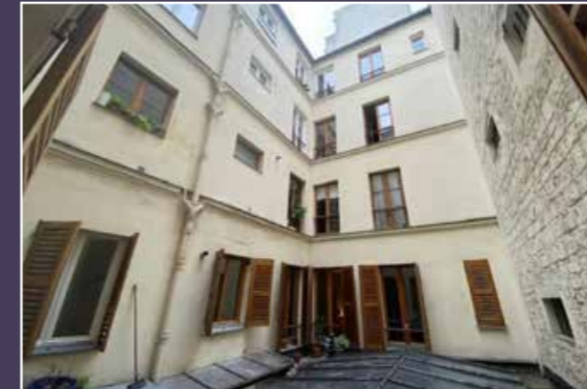
Vue de la cour, comblée au rez-de-chaussée.
