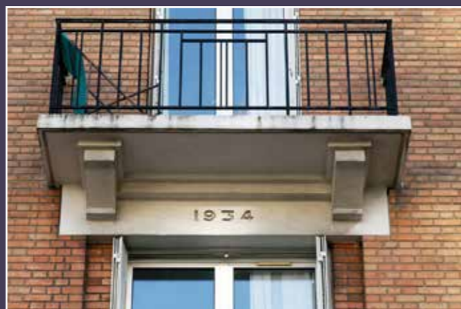
Détail d'un garde-corps, 2024 (© DHAAP /ML).
