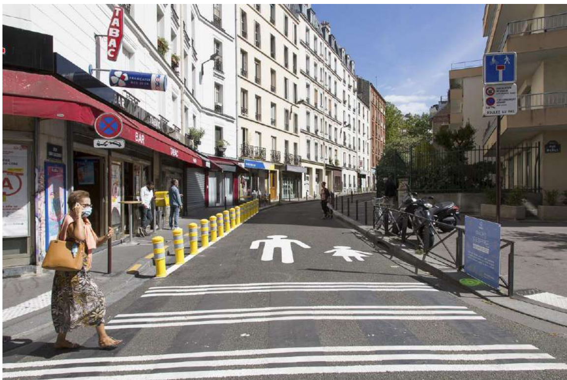
Marquage spécifique parisien dénommé "portée 3 lignes" d'accès et de sortie dans une aire piétonne - Crédit Paris.fr
