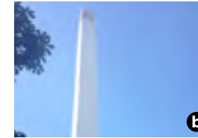
La cheminée du Front de Seine, 4 ème plus haut édifice de Paris: 130 mètres.
