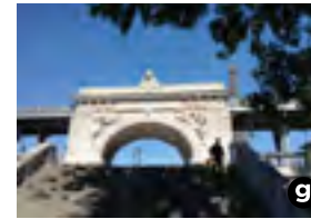
Le pont Bir-Hakeim et le viaduc de Passy.
