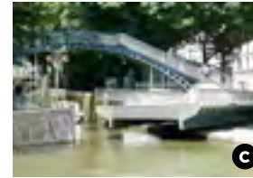
Le pont tournant de la rue de la Grange-aux-Belles, devant l'écluse des Récollets.
