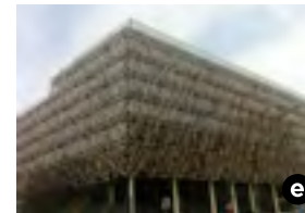
Le chantier du «Nid», signé Rudy Ricciotti.
