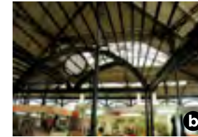
La halle et la verrière du marché Saint-Quentin.
