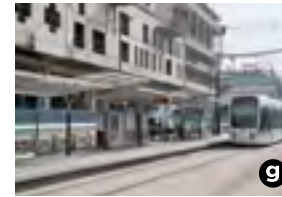
La station de tramway et la future gare Rosa Parks.
