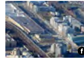
Les immenses entrepôts Macdonald (600 m de long), actuellement en chantier.
