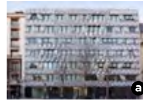
L'immeuble Origami de Manuelle Gautrand, inspiré des techniques de pliage de papier (2007).
