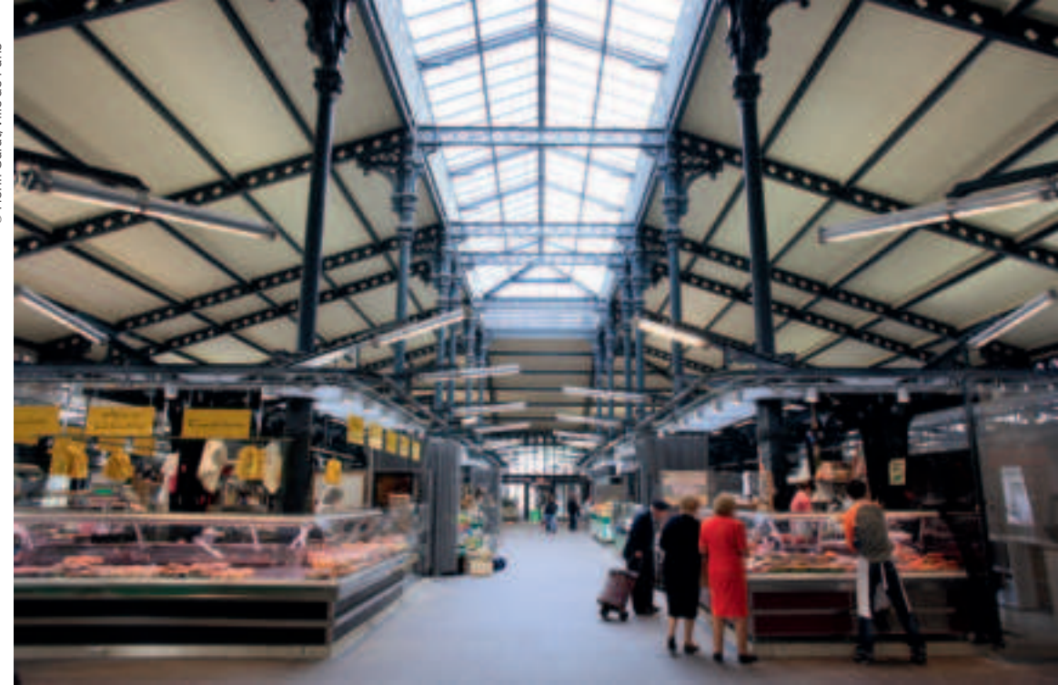
LE MARCHÉ COUVERT LA CHAPELLE RUE DE L'OLIVE (18 E ) dont le bâtiment a été édifié en 1888 dans son style Baltard actuel
