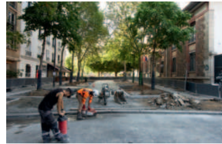
LES TRAVAUX D'AMÉNAGEMENT DE LA « RUE AUX ÉCOLES » AVENUE STÉPHANE PICHON (13 E ) débitumisation et végétalisation
