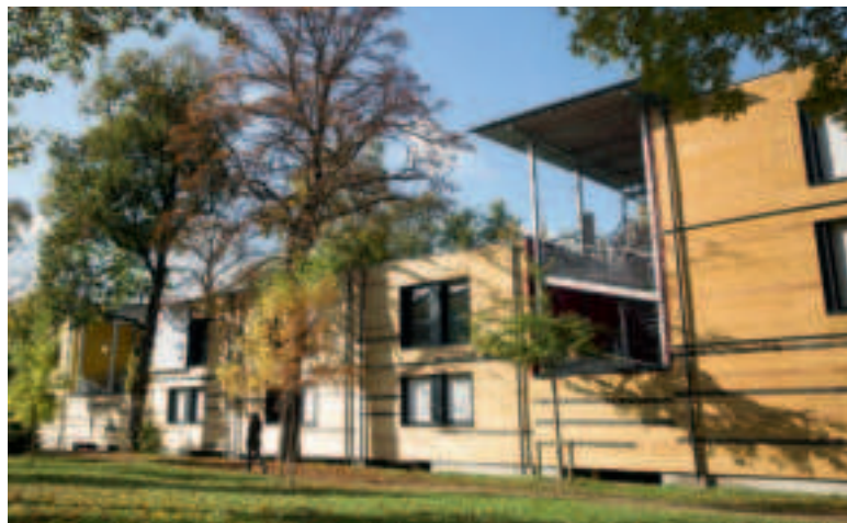
CENTRE D'HÉBERGEMENT D'URGENCE DU BOIS DE BOULOGNE (16 E ) conçu par Moon Architecture et Air Architecture : construire de manière agile pour se donner les moyens d'accueillir celles et ceux qui ont en besoin
