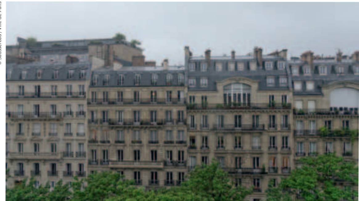
SUCCESSION DE FAÇADES D'IMMEUBLES HAUSSMANNIENS, AVENUE CARNOT (17 E ) bien que dépareillées, elles partagent une écriture commune
