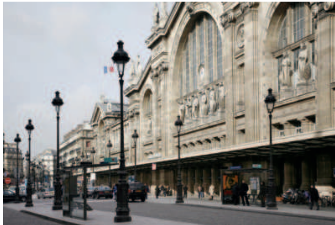
FAÇADE DE LA GARE DU NORD (10 E ) construite par l'architecte Jacques-Ignace Hittorff, vue de la rue de Dunkerque, les gares parisiennes, hauts lieux de style et de décor
