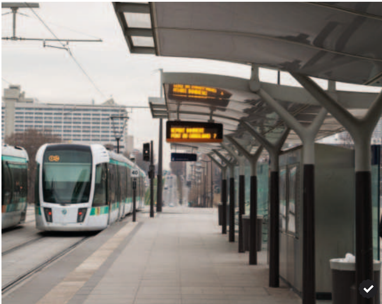
STATION DE LA LIGNE T3
