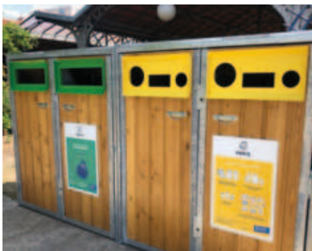
COLLERETTE AU NIVEAU DES ORIFICES DES ABRIS-BACS
