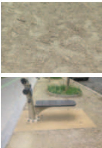
Terre-plein boulevard de Charonne - 20 e
