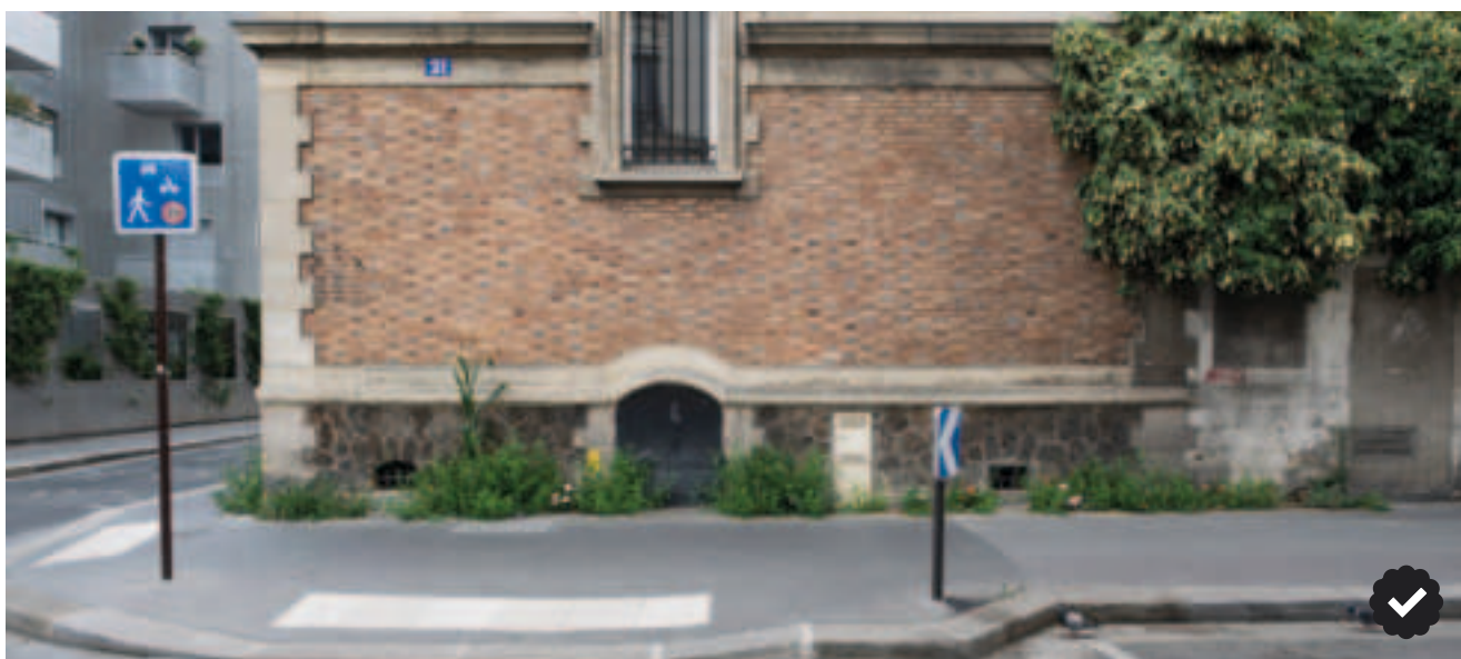
RUE DE COULMIERS - 14°
