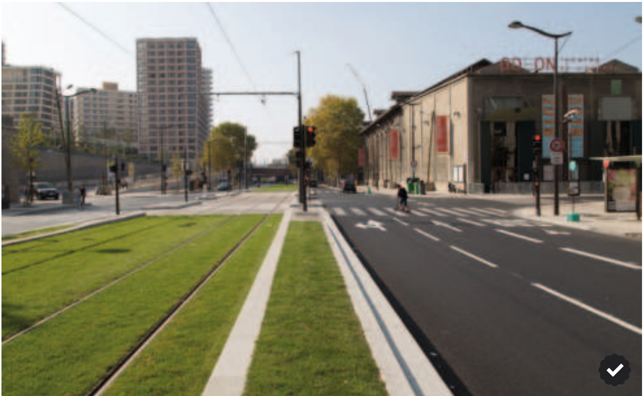
AMÉNAGEMENTS DU T3B AU NIVEAU DE LA PORTE DE CLICHY - 17°
