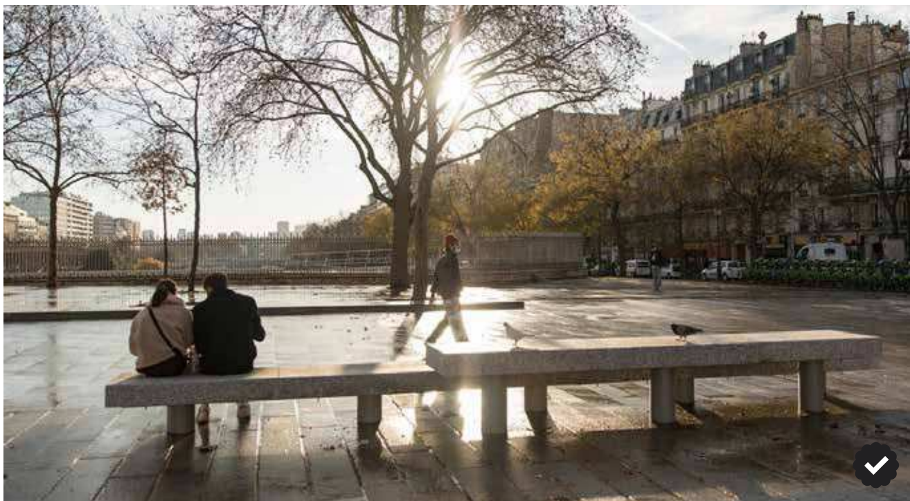
BANCS EN BORDURES DE TROTTOIR RECYCLÉES AVEC FONCTION ANTI-BÉLIER PLACE DE LA BASTILLE - 4 e , 11 e , 12 e
