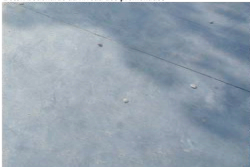
Béton type Surfaplan au niveau des parvis et des seuils
