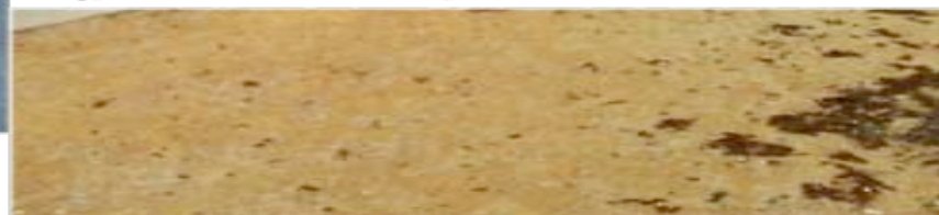
Sol stabilisé au niveau de l'aire de convivialité
