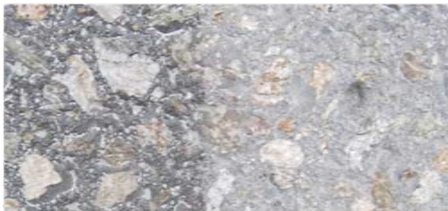
Béton bouchardé au niveau des promenades
