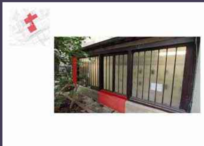
Démolitions, galerie de jonction (© Franklin Azzi Architecture).
