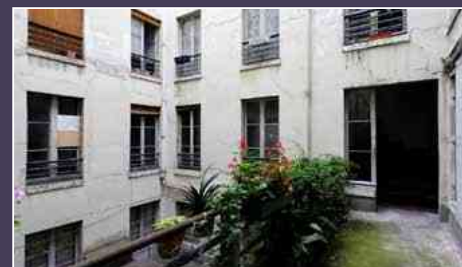
Vue actuelle de la cour et de la passerelle reliant les deux escaliers, 42, rue de la Verrerie.
