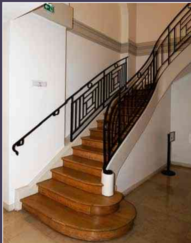
Vue actuelle de l'escalier menant aux bureaux.
