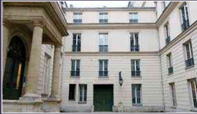
Vue de l'aile est sur cour.
