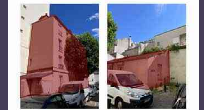
Photographies des bâtiments dont la démolition était demandée, projet présenté en juin 2022 (© BFV architectes).
