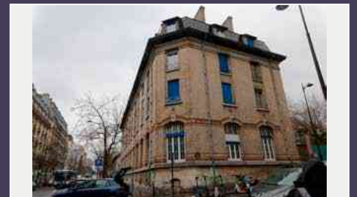
Vue depuis l'angle de la rue de Rambervilliers et de l'avenue.
