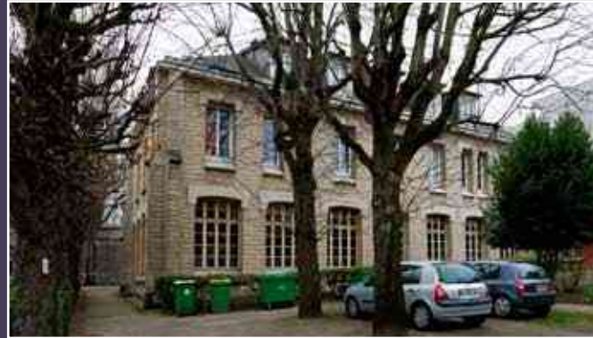
Vue actuelle du bâtiment conventuel.
