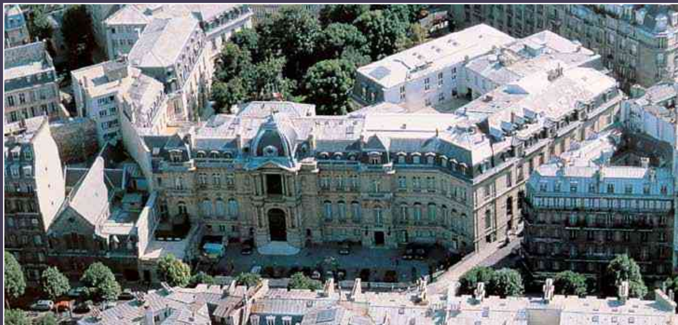
Vue aérienne du site de la Chambre de Commerce de Paris, datant de 1993 (étude REA).
