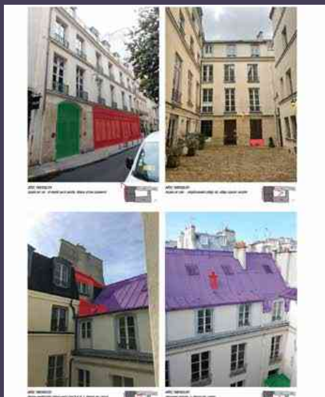
Vue des démolitions et interventions, corps de logis (© Franklin Azzi Architecture).
