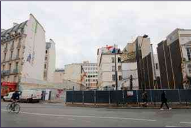
Vue de la parcelle après démolition, 2022.
