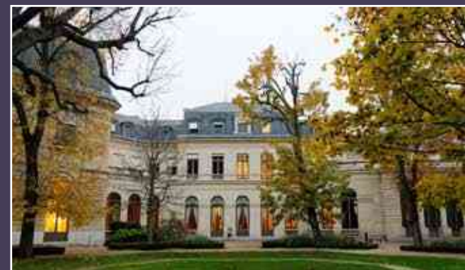
Vue actuelle des façades arrière depuis le jardin du site.
