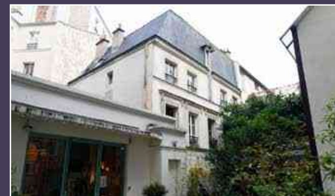
Vue du pavillon d'origine sur cour.
