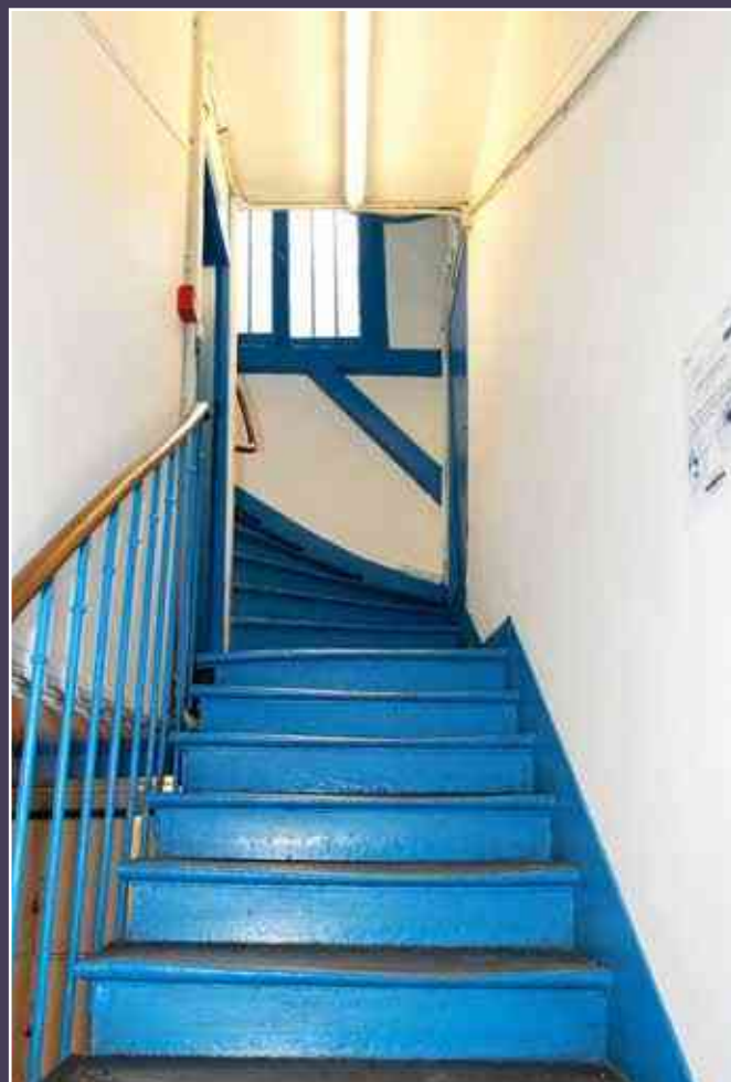
Vue de l'escalier des ateliers à reconstruire.
