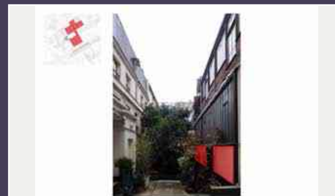
Démolitions, grand atelier sur cour (© Franklin Azzi Architecture).
