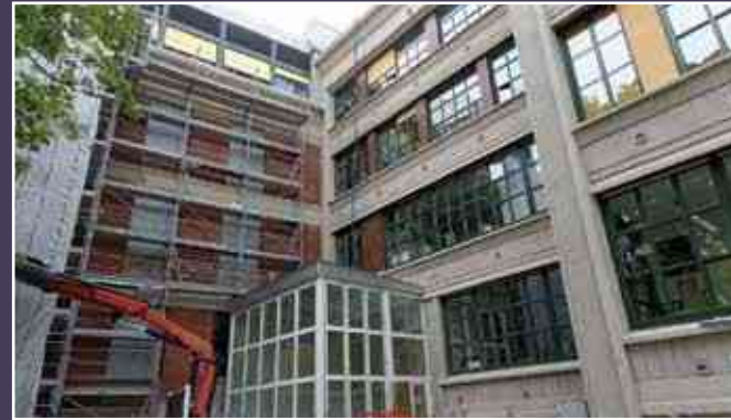
Travaux de rénovation et construction d'un sas en 2015.
