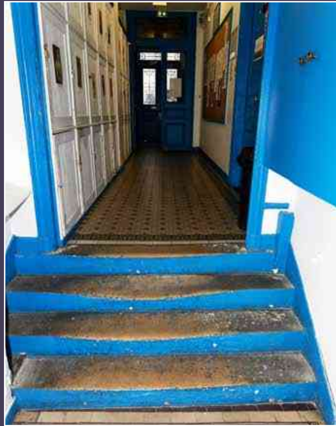
Vue de la jonction avec la galerie.
