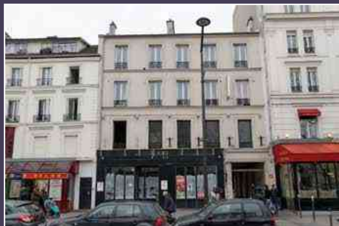
Vue de la façade de l'immeuble sur rue (2014).
