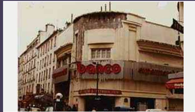
Vue du bâtiment au début des années 1980.
