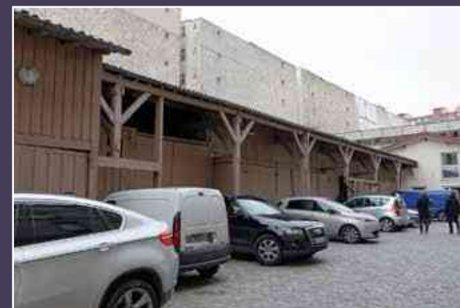
Hangars « à sept travées » (2014).
