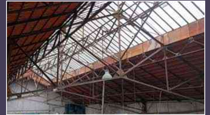
Vue actuelle de la charpente métallique.
