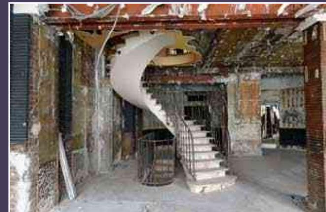
Escalier de la petite aile sur cour (2014).
