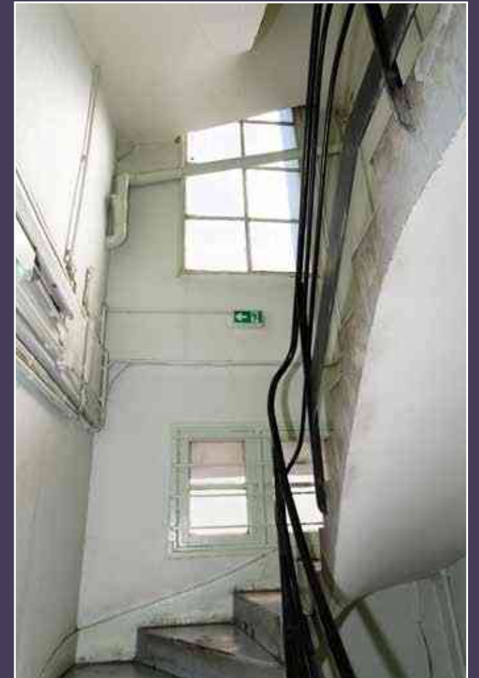
Vue actuelle de l'escalier.
