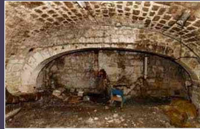
Vue actuelle des caves du 14, rue du Temple.
