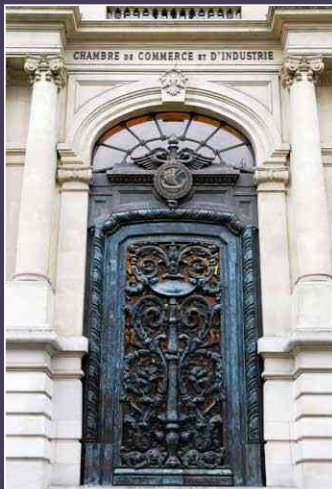
Vue actuelle de l'entrée du bâtiment principal donnant sur l'ave-nue de Friedland.
