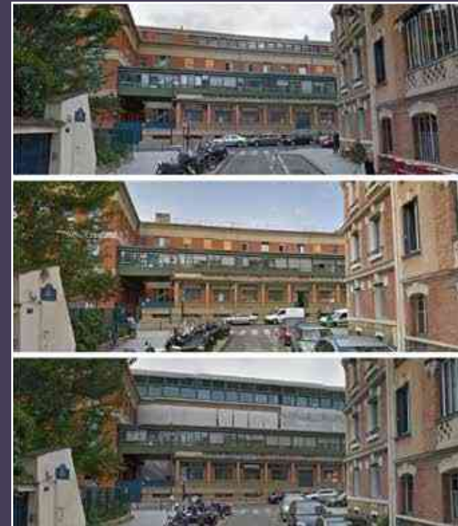
Évolution du bâtiment rue Lhomond entre 2012 et 2015 (© Google).
