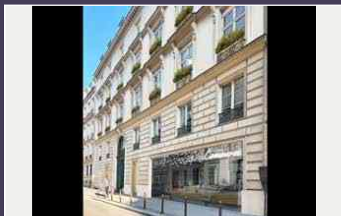
Vue de la façade sur rue, projet présenté en février 2022 (© Architecture Studio).
