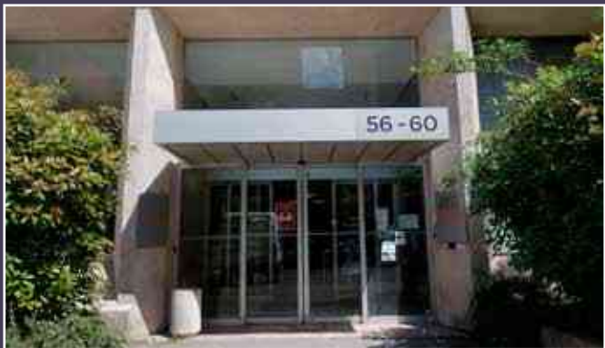
Vue actuelle de l'entrée du bâtiment.
