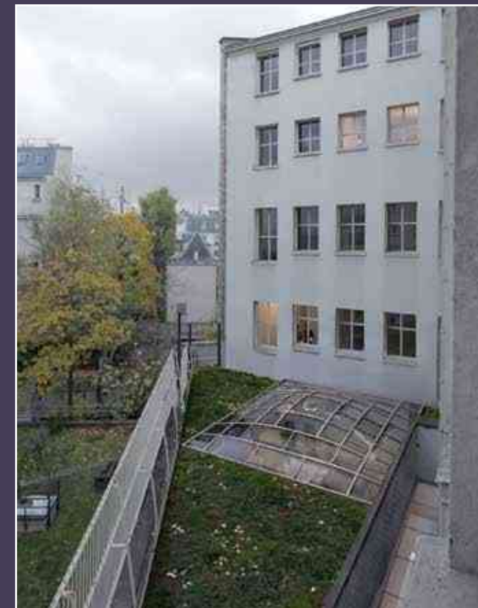
Insertion du projet dans le toit-terrasse de l'aile Chateaubriand (© h2o Architectes).
