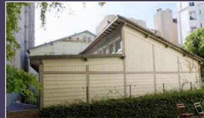
Vue de l'arrière des bâtiments depuis le jardin de la parcelle voisine, 2019 (© DHAAP / ML).
