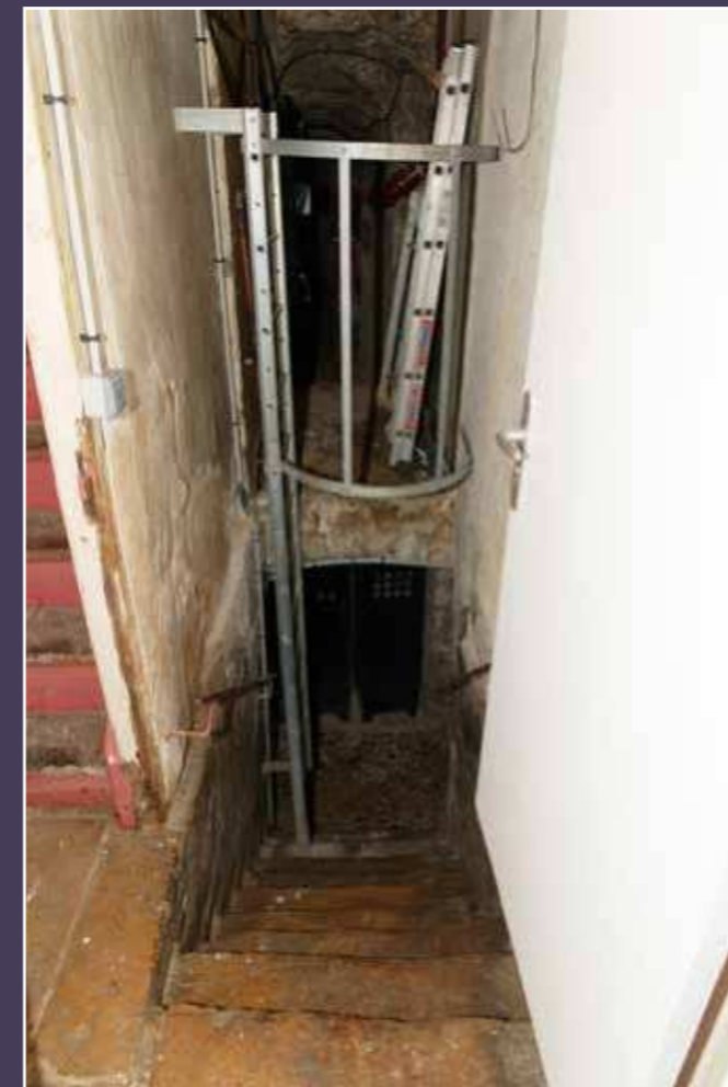
Vue de l'accès aux caves, 2024 (© DHAAP / ML).
