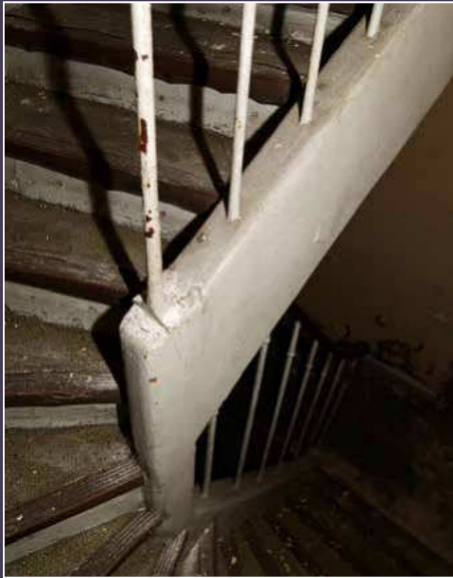
Vue de l'escalier du bâtiment D, promis à la démolition, 2024 (© DHAAP / ML).
