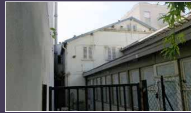
Vue du bâtiment sur rue et de la grande salle des années 1960, depuis le coeur d'îlot, 2019 (© DHAAP / ML).
