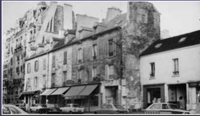
Photographie, avant démolition, du 203 et du 205 rue de Charenton, 1969 (© DHAAP / CVP).
