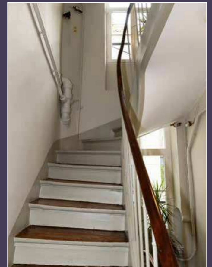
Vue de l'escalier, 2024 (© DHAAP / ML).
