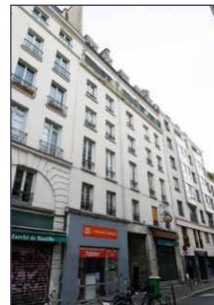
Vue de la façade sur rue, 2024 (© DHAAP / ML).
