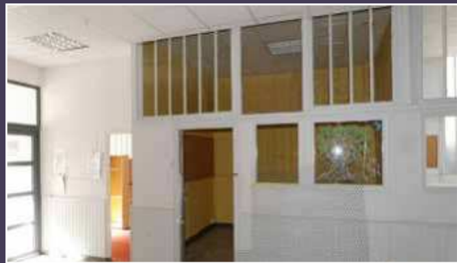
Vue du cloisonnement intérieur d'origine, 2019 (© DHAAP / ML).
