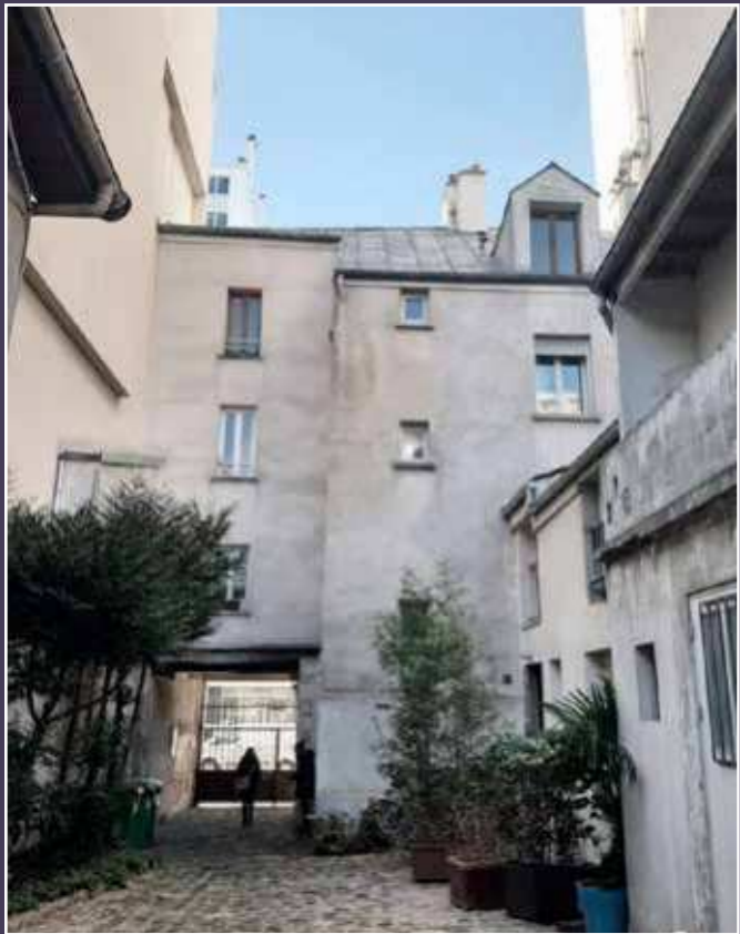
Vue de la façade arrière depuis la cour (© Thomas Dryjski architecte).
