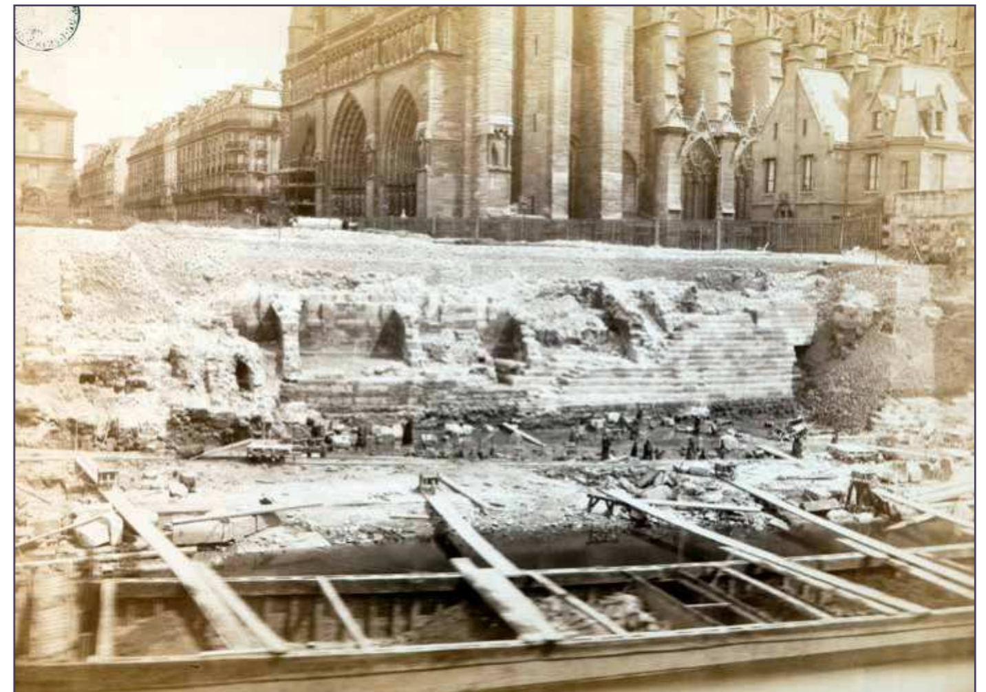
Fig. 19 - Vue des cagnards, en cours de démolition, après 1878 (BHVP, MA_Vacquer_MS255_f044).
