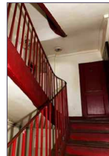
Vue de l'escalier, 2024 (© DHAAP / ML).
