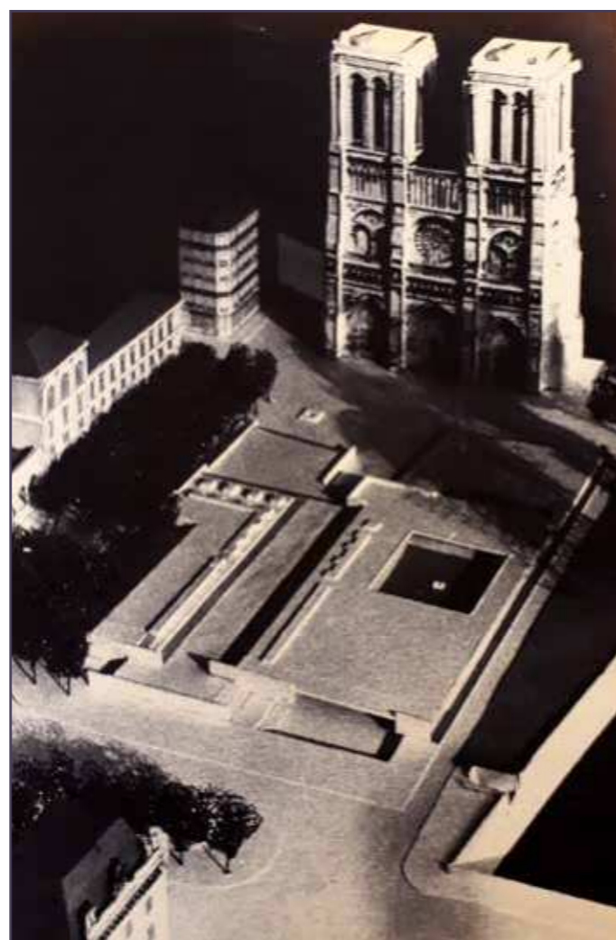
Fig. 40 - Proposition pour un parvis dalle, crypte archéologique, salle d'accueil et patio. Photo d'une maquette au 1/500 réalisée en janvier 1970 (André Hermant et Jean-Pierre Jouve, Etudes et propositions pour l'aménagement du parvis de Notre-Dame et de ses abords , Paris c.1970 - Bibliothèque de l'Hôtel de Ville, 40539 / tr 23).
