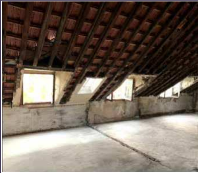
Vue de la charpente avant transformation des combles en appartement (© GMV architectes & associés).
