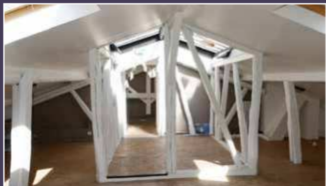
Vue de la charpente du bâtiment sur rue, 2019 (© DHAAP / ML).
