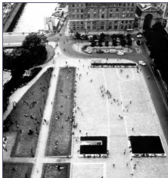
Fig. 48 - Aménagement du parvis à l'issue des travaux en 1975 (paru dans Autour de Notre-Dame , Baskerville, 2003, p. 35). Cette photographie montre la place, telle qu'elle fut aménagée, d'après la dernière version du projet d'Hermant et Jouve (1972).
