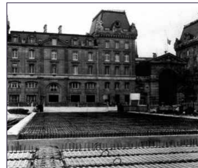
Fig.34 - Bétonnage du parvis, janvier 1972 (Direction de la Voirie et des Déplacements, paru dans Autour de Notre-Dame , Baskerville 2003, p. 281).
