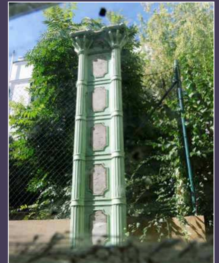
Vue d'une des colonnes jumelées en fonte, située dans le jardin, 2019 (© DHAAP / ML).
