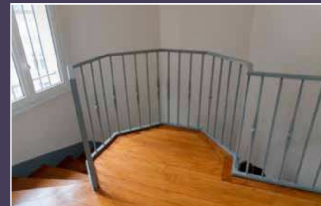
Vue de la dernière volée de l'escalier principal, 2021 (© DHAAP / PS).
