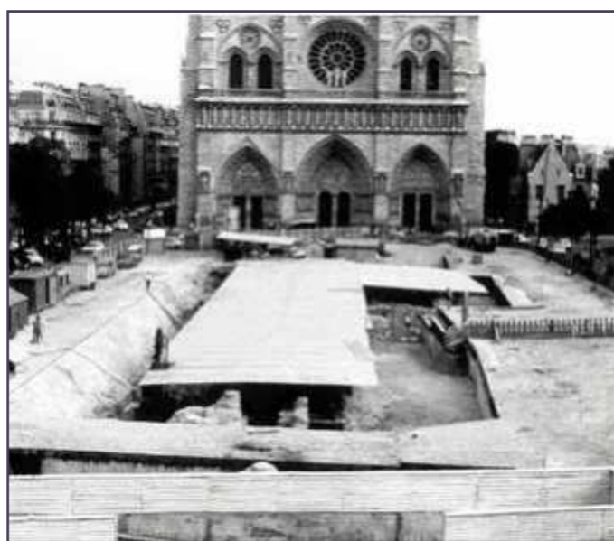
Fig. 32 - Vue sur le chantier de fouilles archéologiques depuis la préfecture de Police, septembre 1971 (Direction de la Voirie et des Déplacements, paru dans Autour de Notre-Dame , Baskerville 2003, p. 280).
