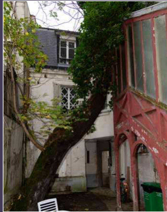
Vue de l'escalier extérieur du bâtiment E, promis à la démolition, 2024 (© DHAAP / ML).
