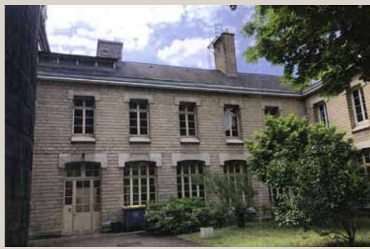
Vue actuelle de l'extension. Les deux premières travées de gauche, qui font la jonction avec le deuxième bâtiment conventuel, seront démolies.
