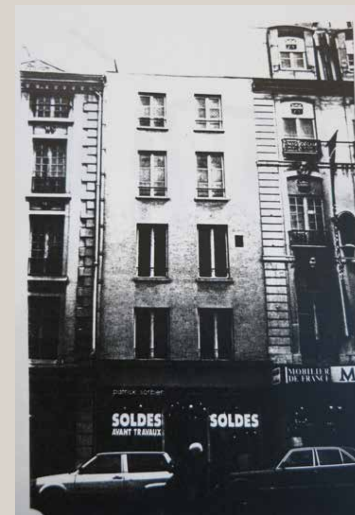
Vue de la façade sur la rue du Faubourg-Saint-Antoine avant les travaux de 1993 (Archives de Paris).
