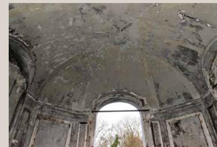
Vue de la voûte du salon du premier étage.
