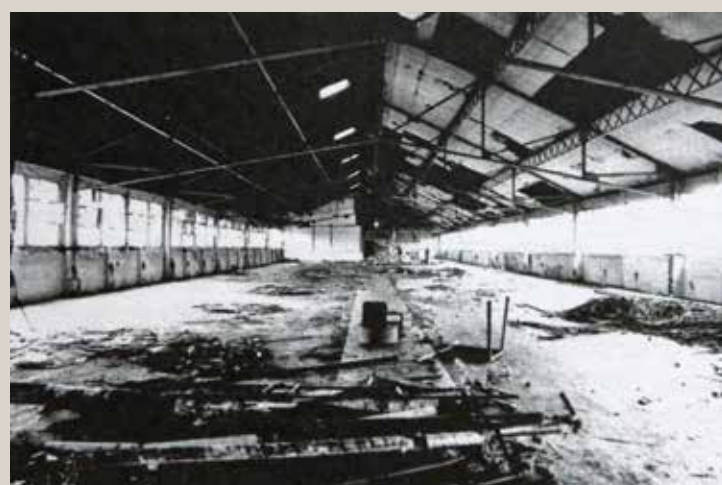
Élévation (détail) de la halle supérieure avant les travaux de 1975 (repr. dans AUA, 2015).
