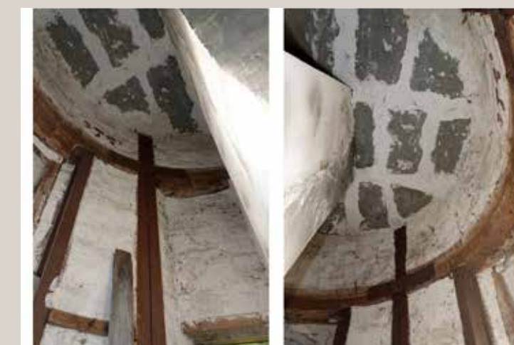
Vues intérieures du belvédère et du passage de la cheminée..
