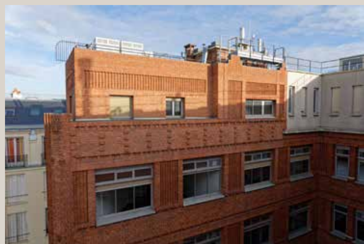
Vue actuelle des dernières étages d'une aile du bâtiment Édimbourg.
