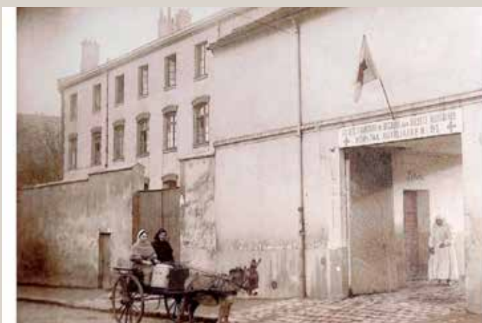
Vue de la porterie du couvent transformé en hôpital pendant la guerre 1914-1918. En arrière-plan, le bâtiment historique de la communauté (archives de la maison-mère des sœurs franciscaines de Marie).
