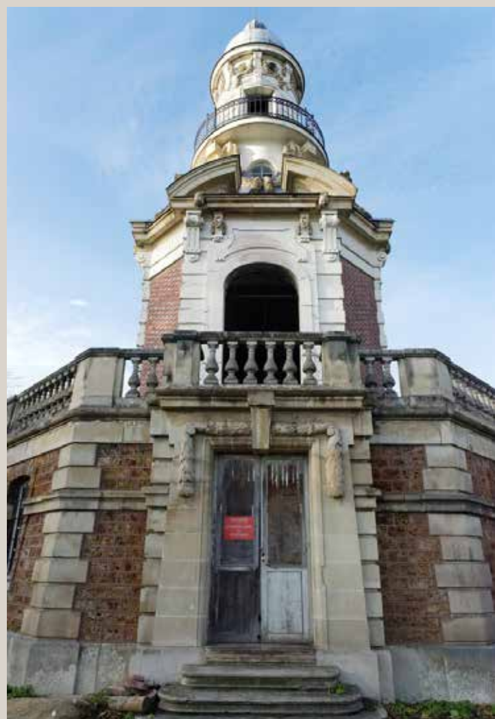
Vue actuelle de la pompe à feu.
