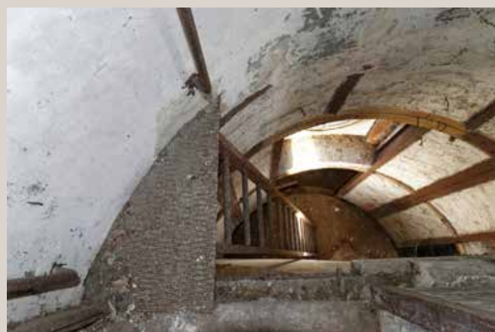
Vue de l'échelle qui permet l'accès au belvédère.
