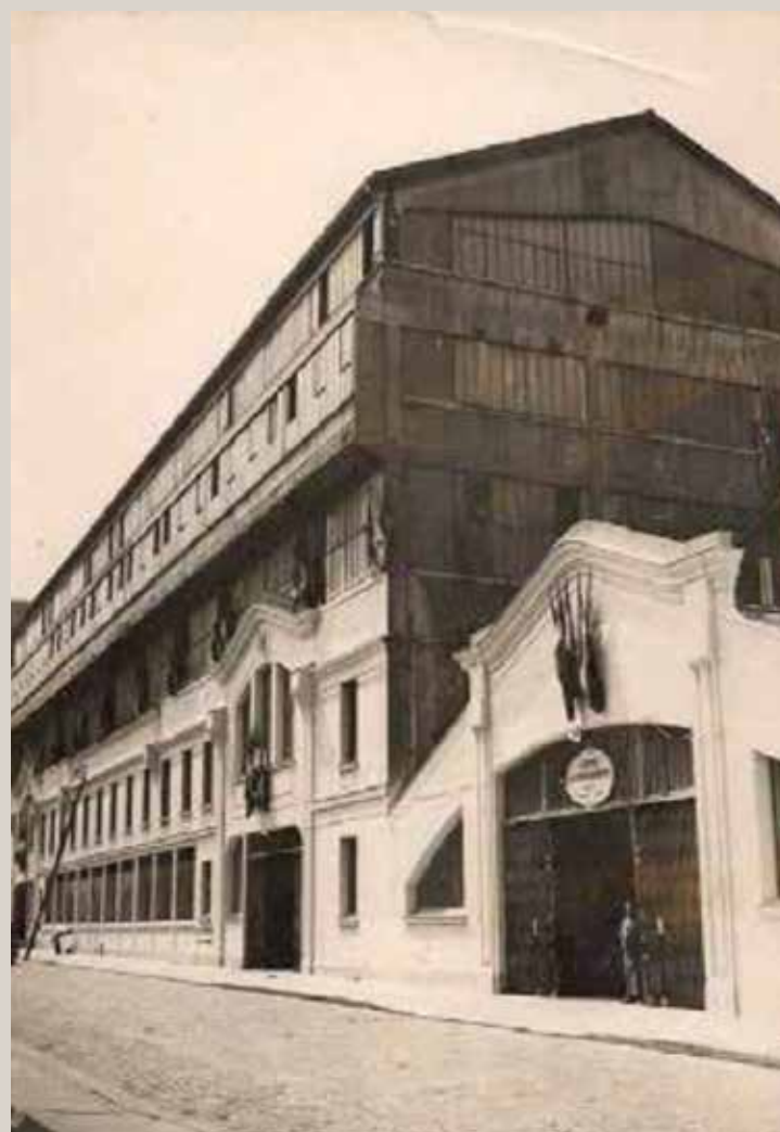
Élévation du bâtiment sur la rue avant les travaux de 1952 (documentation du permis de construire).
