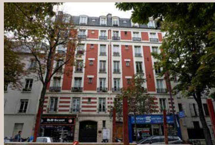
Vue actuelle de la façade sur la rue de Bagnolet.
