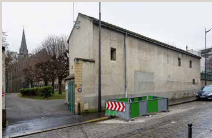
Une des petites constructions en bordure de l'impasse Reille destinée à la démolition.
