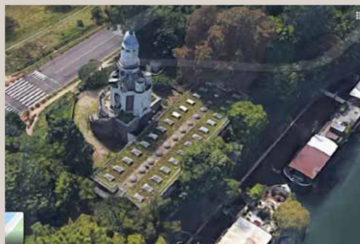
Vue aérienne de la pompe à feu (source : Internet).
