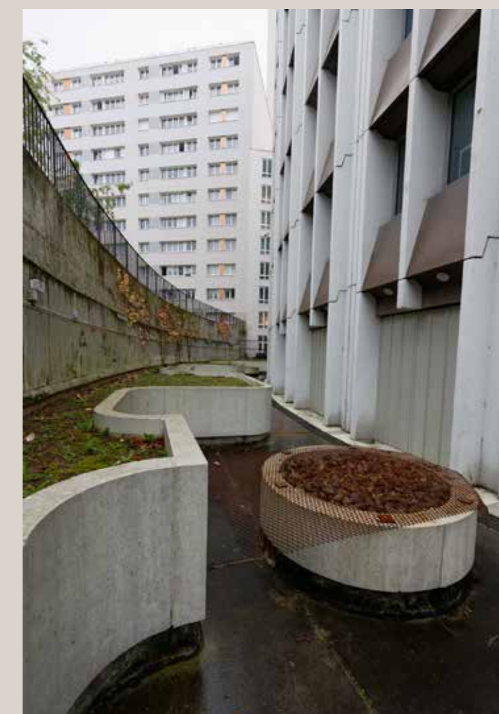
Vue actuelle de la cour et de la façade sur cour.
