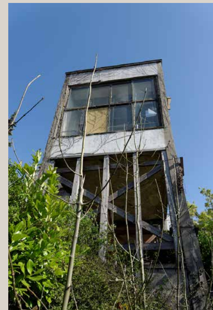
Vue du volume sur pilotis en 2014.
