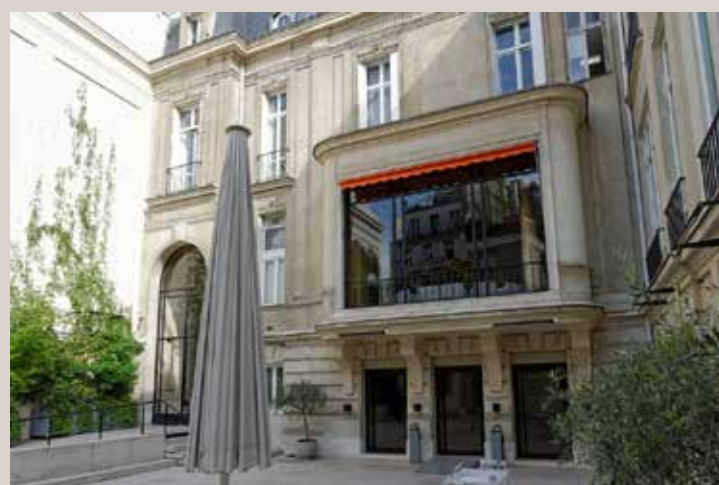
Vue actuelle de la façade de l'hôtel particulier, côté cour.
