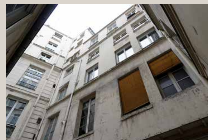
Vue des façades sur cour.
