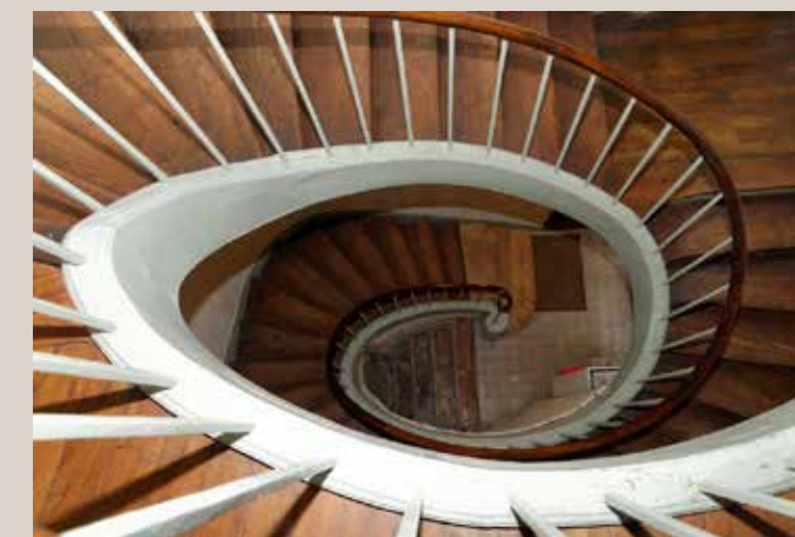
Vue actuelle de l'escalier principal.
