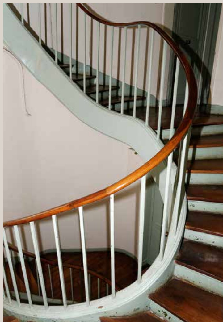
Vue de l'escalier dans sa partie basse.
