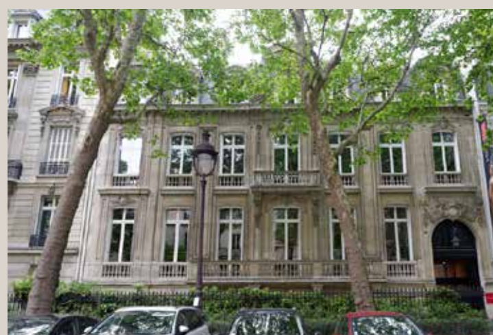
Vue actuelle de la façade de l'hôtel particulier, côté avenue.
