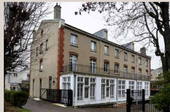
Vue actuelle du bâtiment dit des « Quatre Vents ».
