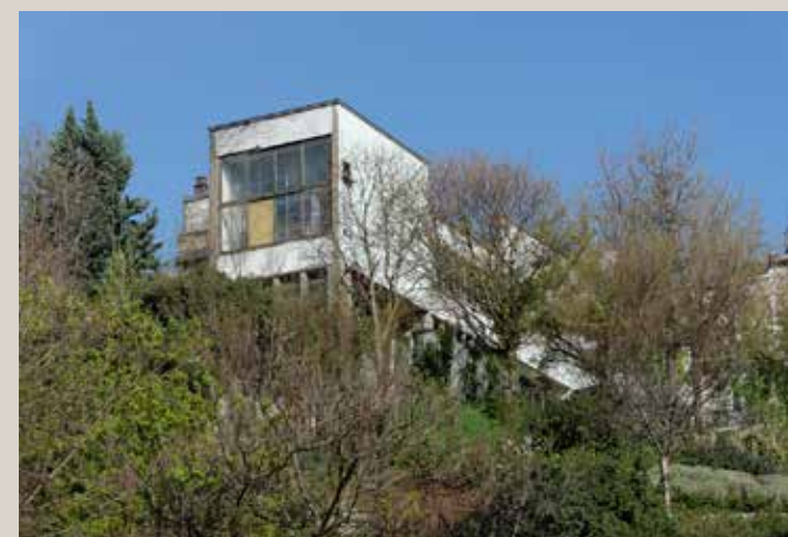
Vue lointaine du bâtiment depuis le bas de la pente, en 2014.
