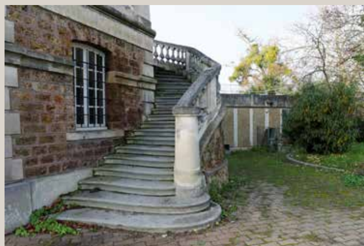
Vue actuelle du départ de l'escalier.
