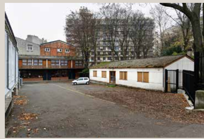
Vue actuelle du bâtiment situé en bordure de l'EVP. Sa démolition est envisagée.
