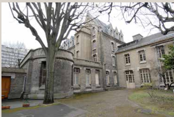
Vue de l'extension du bâtiment conventuel.
