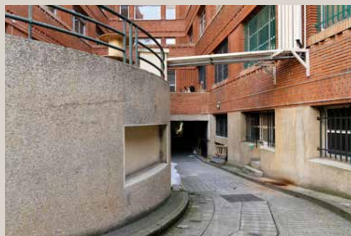
Vue actuelle de la rampe véhicules conduisant au sous-sol, du mur courbe de soutien de la terrasse et du soubassement du bâtiment Édimbourg.
