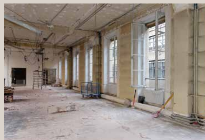
Vue actuelle d'un étage courant d'une des ailes de la cour des recettes.
