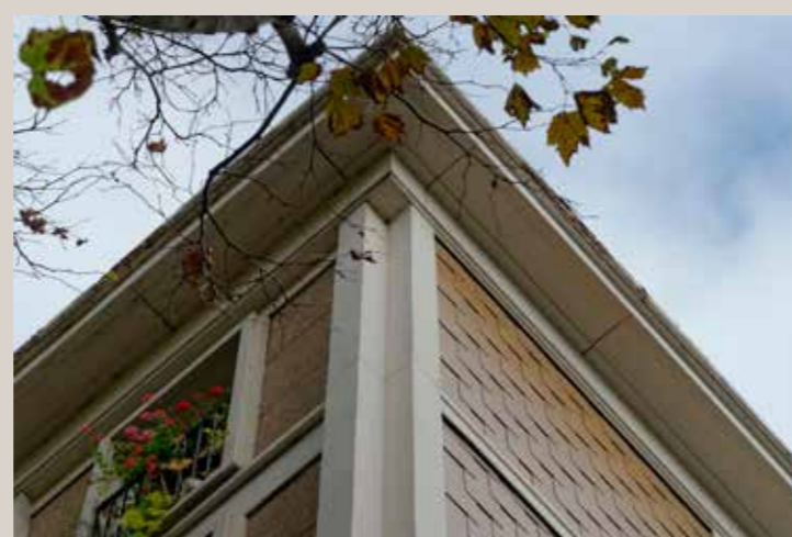
Détail d'une corniche et d'un pignon.
