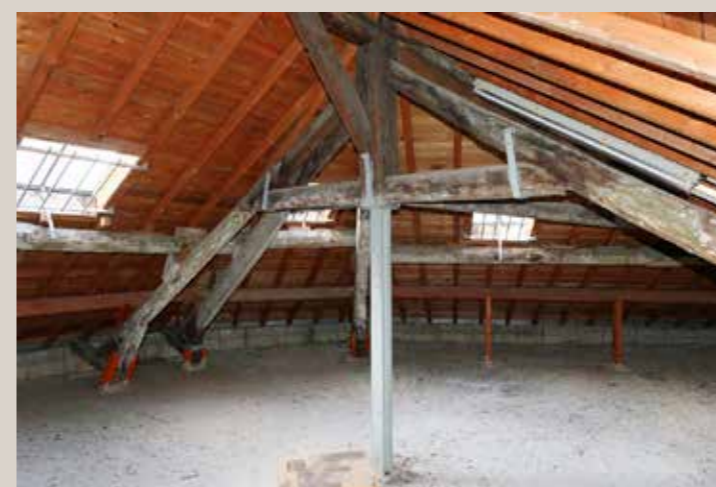
Vue de la charpente de la maison d'angle.
