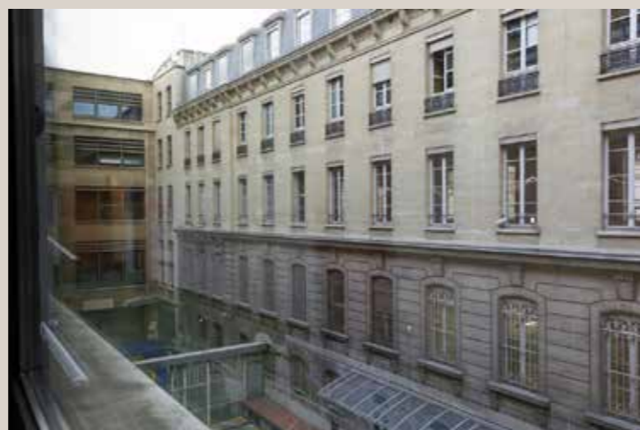
Vue de l'actuelle cour n° 8 longeant le bâtiment de l'ancienne cour des recettes.
