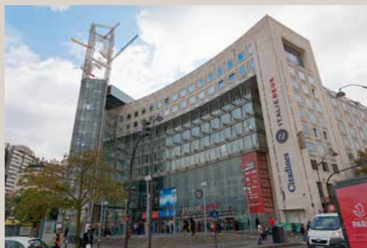
Vue actuelle de la façade incurvée depuis la place.
