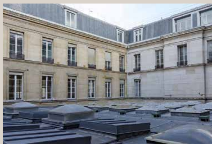
Vue du plafond vitré de l'ancienne cour des recettes.
