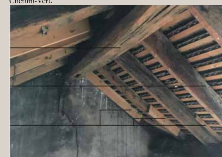
Vue de la charpente côté est du bâtiment.
