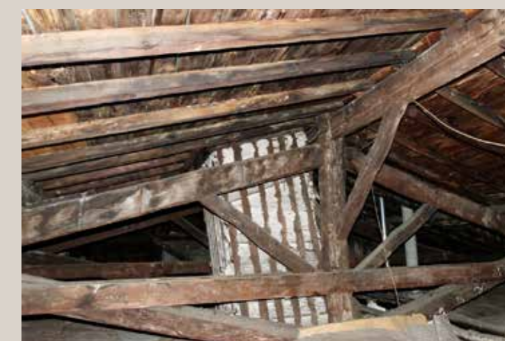
Vue actuelle de la charpente.
