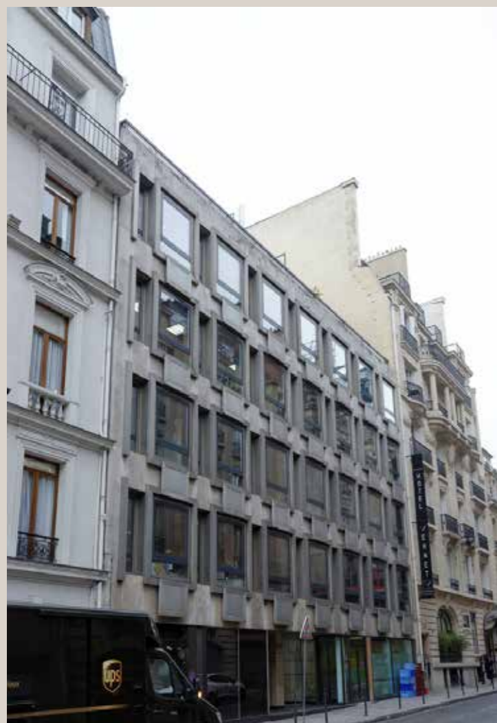
Vue actuelle de la façade sur la rue Vernet.
