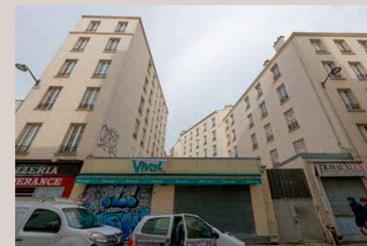
Vue frontale des bâtiments concernés par la démolition.
