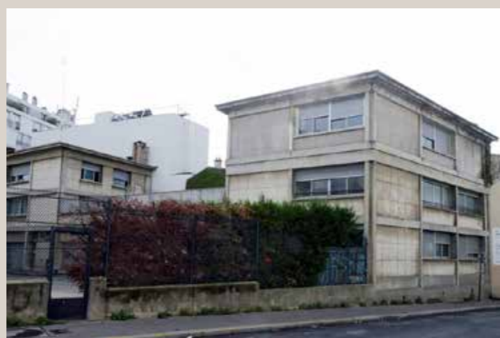
Vue actuelle de la façade sur la rue Manouchian.
