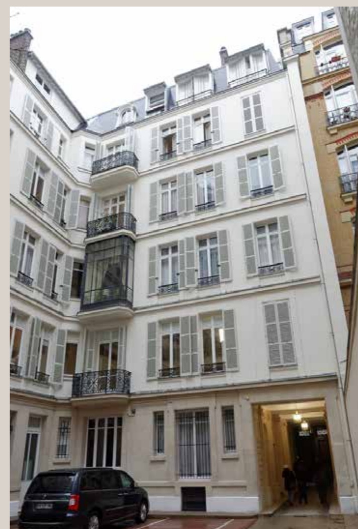
Vue actuelle de la façade arrière.
