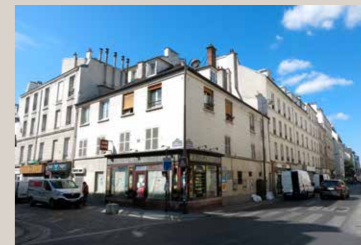
Vue actuelle de la maison depuis l'angle des rues Popincourt et du Chemin-Vert.
