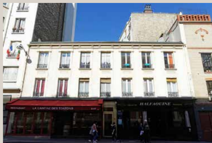
Vue actuelle de la façade sur rue.
