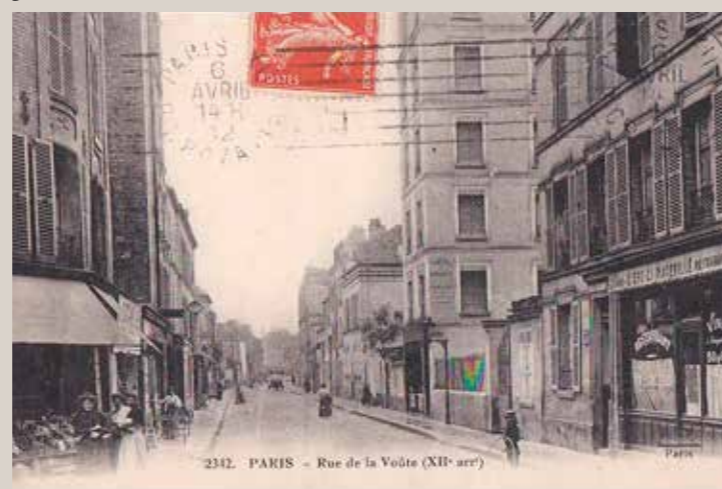
Vue ancienne de la rue de la Voûte, au niveau du n° 45, à droite de l'image (Delcampe).
