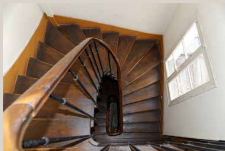
Vue actuelle de l'escalier.
