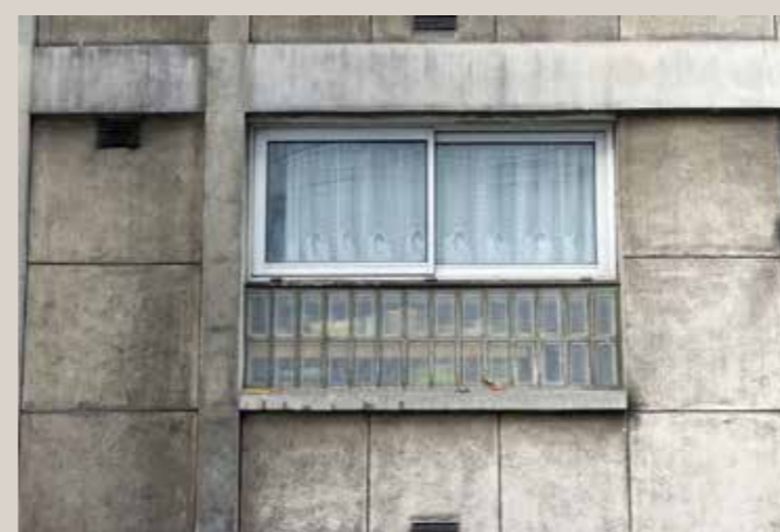
Détail de la façade sur la rue Haxo.
