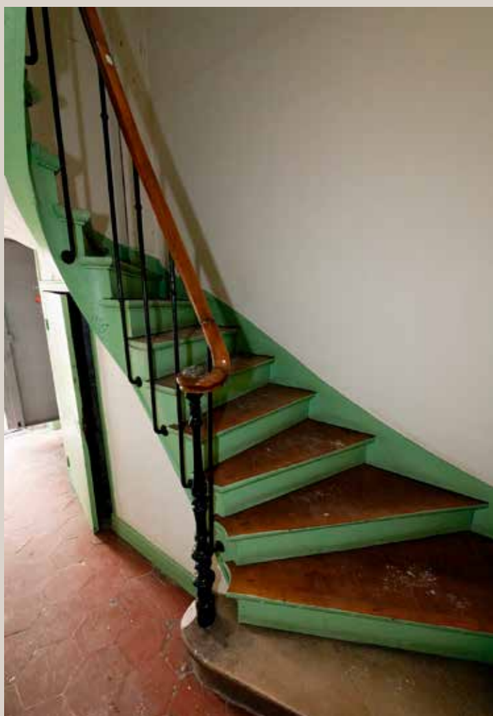
Vue actuelle d'un des quatre escaliers à démolir.
