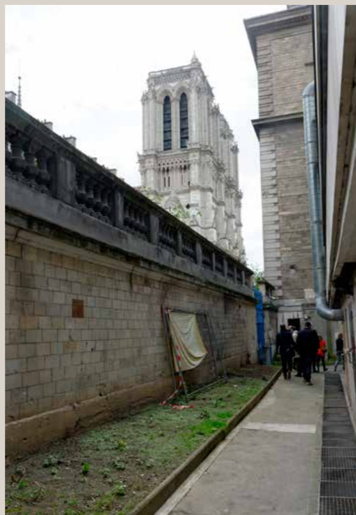
Vue actuelle du mur de clôture d'origine, côté rue d'Arcole.
