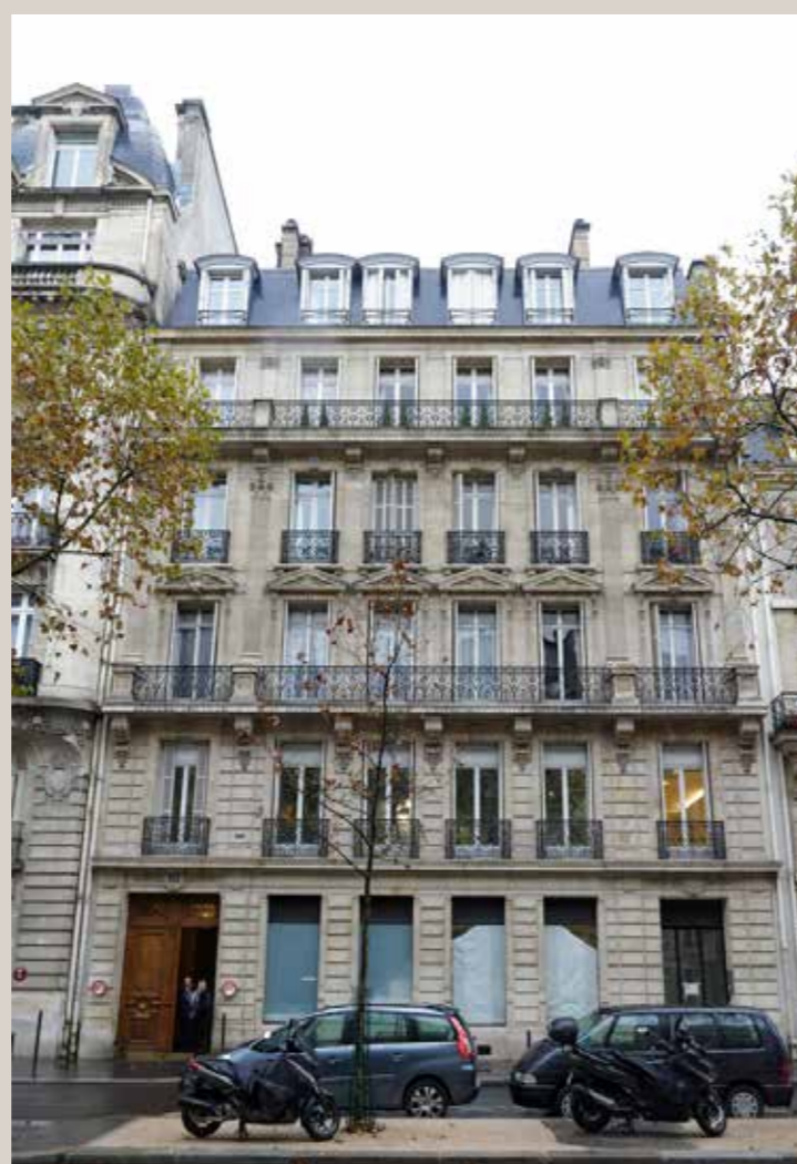
Vue actuelle de la façade sur l'avenue.
