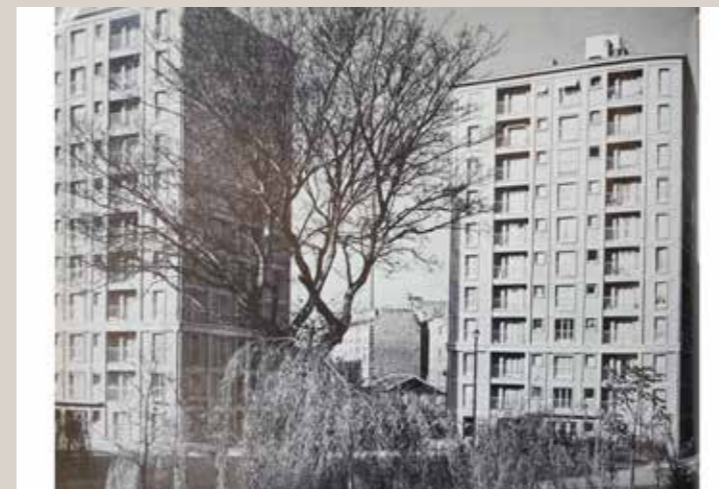
Vue de deux des trois tours au début des années 1960 (publiée dans Techniques & Architecture , juin-juillet 1962).
