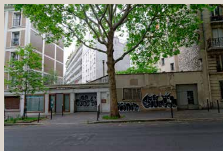
Vue actuelle des bâtiments depuis la rue Armand-Carrel.
