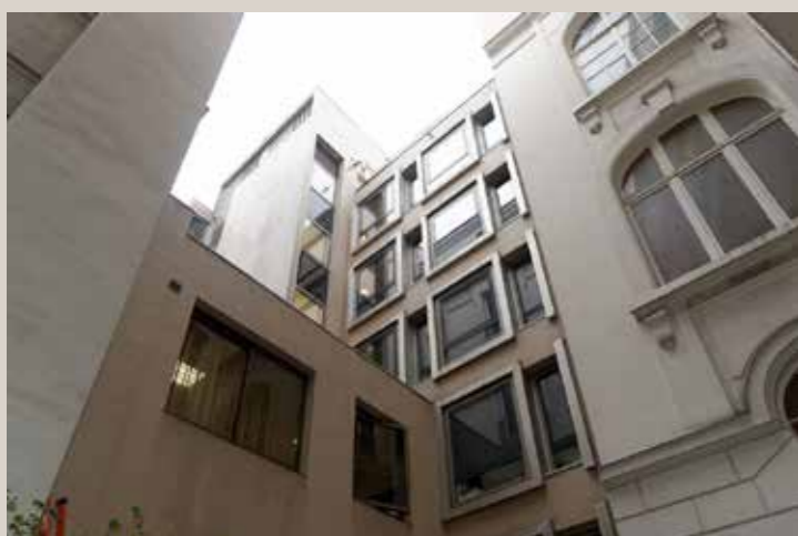
Vue de la façade sur cour du bâtiment de la rue Vernet.
