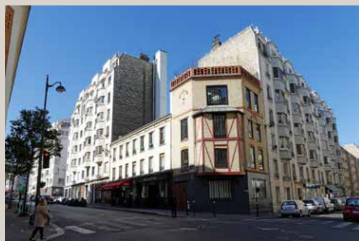
Vue actuelle depuis l'angle des rues de Dantzig et des Morillons.
