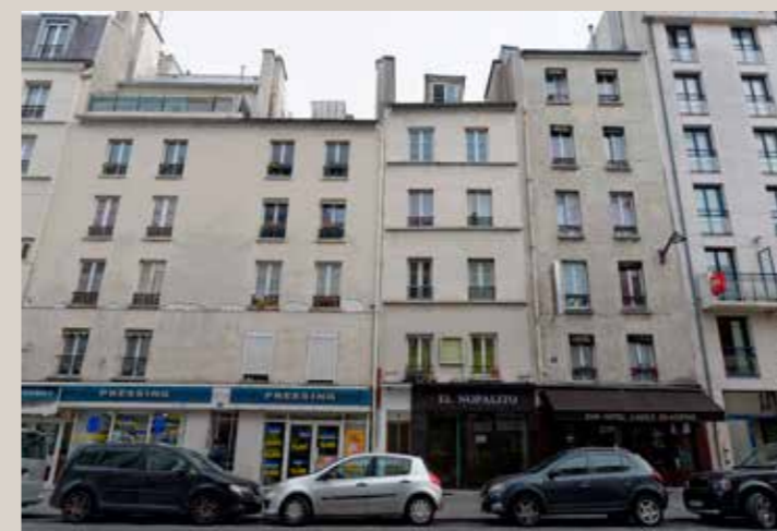
Vue actuelle de la façade sur rue.
