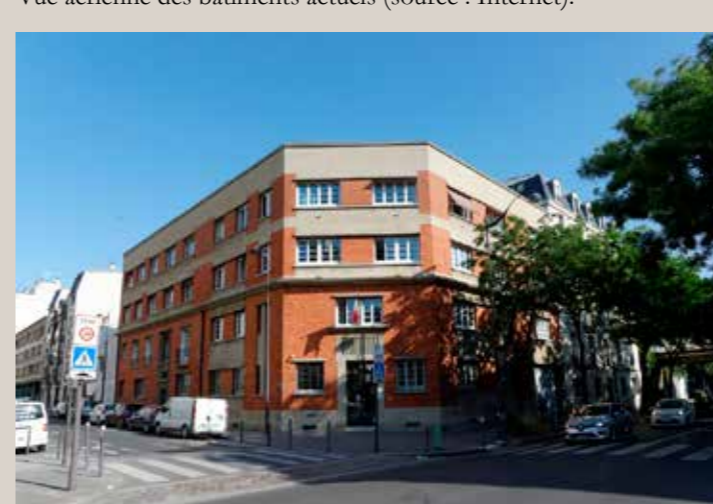
Vue actuelle depuis l'angle des deux voies.
