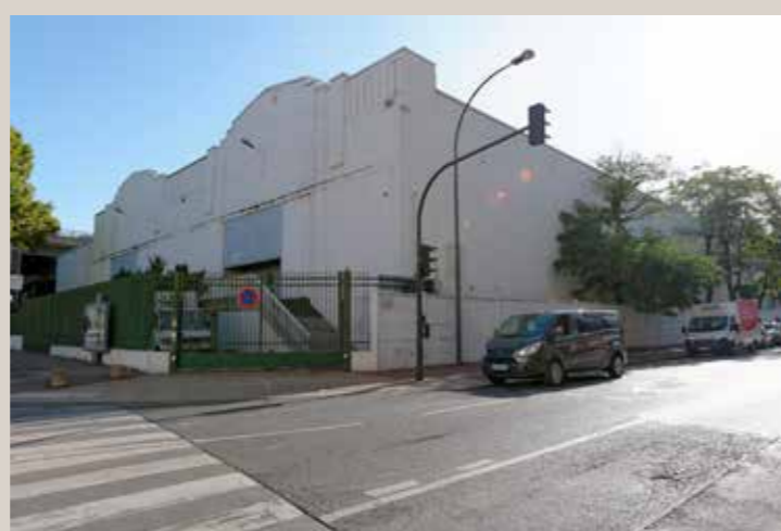
Vue actuelle des deux dernières travées depuis l'angle de l'avenue Ernest-Renan et de l'avenue du 4-septembre.
