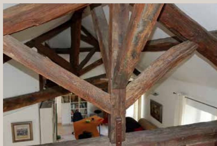
Vue actuelle de la charpente. À droite, l'arrière de la façade sur rue.
