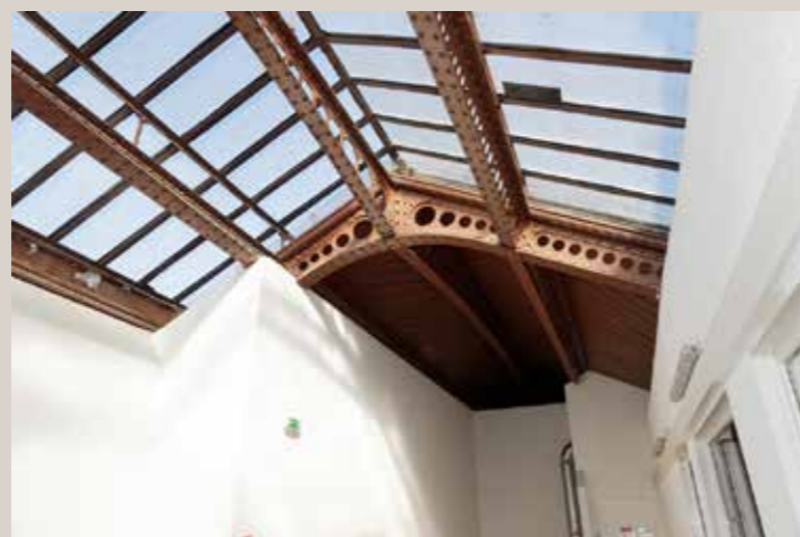
Vue de l'aile latérale côté Arrivée.
