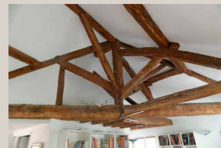
Vue actuelle de la charpente.
