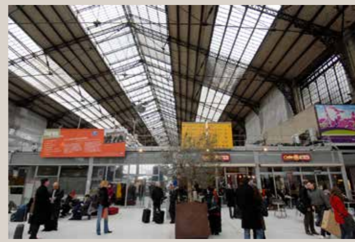
Photographie de la halle principale avant travaux, en 2009.
