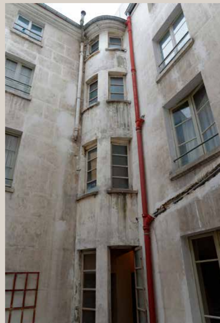
Vue actuelle de l'oriel à l'angle des deux ailes, côté cour.
