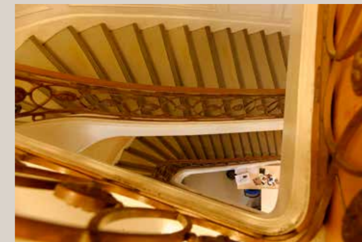
Vue actuelle de l'escalier d'origine (du R+2 au R+4).
