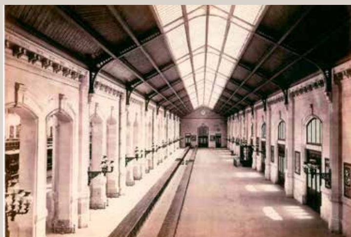
Vue intérieure de la Salle des Bagages au XIX e siècle (Archives Gare & Connexions de la SNCF).
