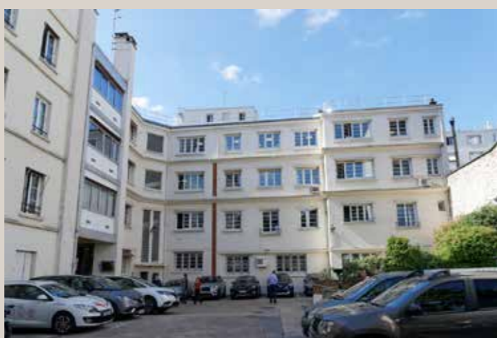
Vue actuelle des façades sur cour.
