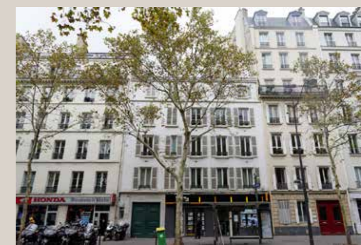
Vue actuelle de la façade sur rue.
