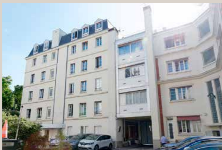
Vue actuelle des façades sur cour. Au milieu, la travée édifiée en 1965.
