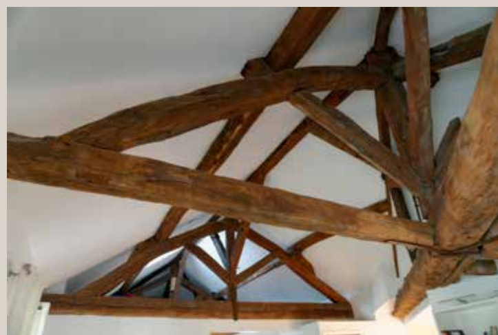
Vue actuelle de la charpente.
