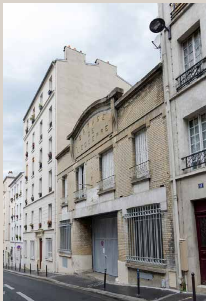
Vue actuelle de la façade sur rue.
