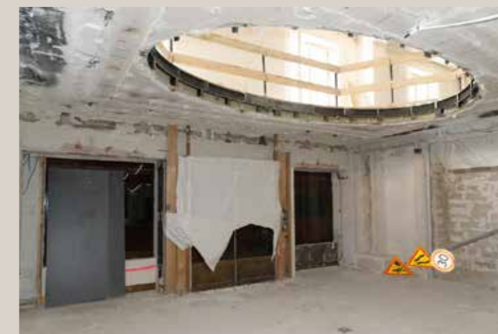
Vue actuelle du rez-de-chaussée et de l'entresol connectés par une trémie existante et dont le plancher est appelé à disparaître entièrement.
