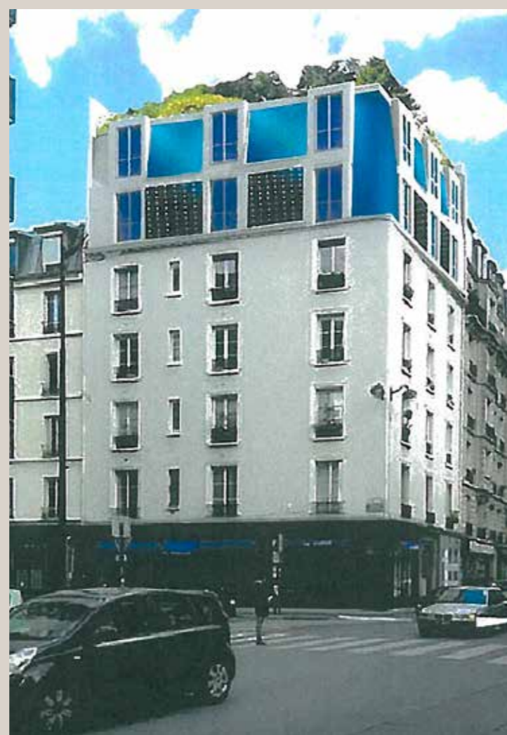
Vue d'insertion du projet présenté en mai 2018 (© Rafati architecte).
