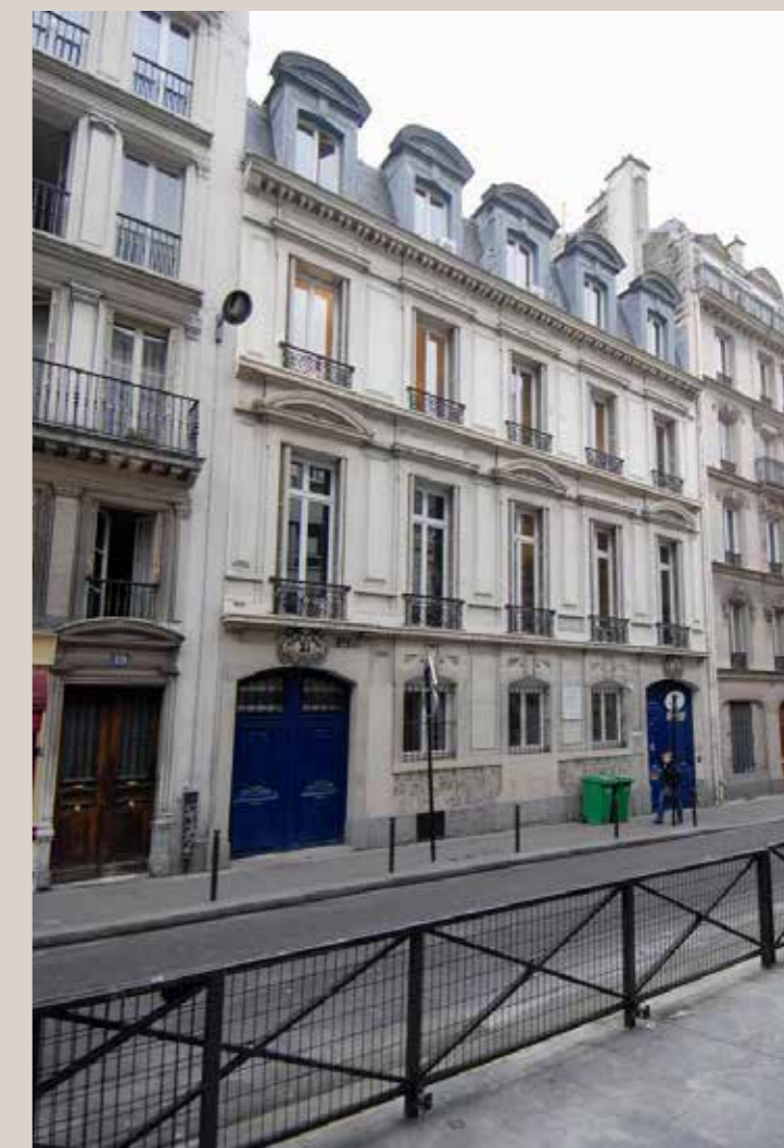
Vue actuelle de la façade sur rue.
