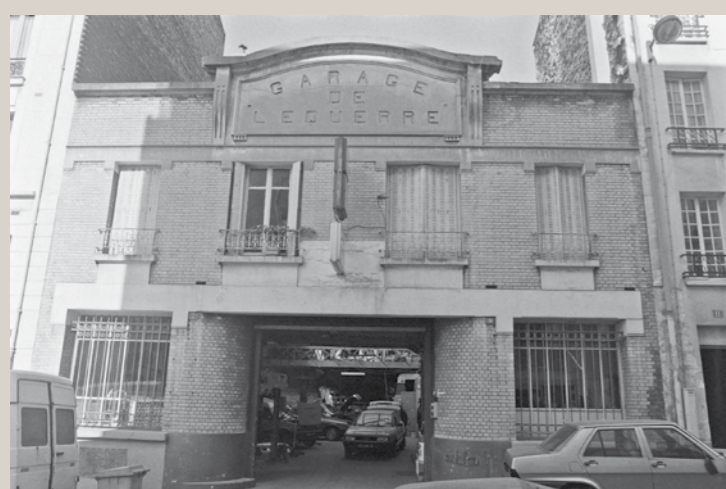
Vue de la façade sur rue en 1989 (© D.H.A.A.P.).
