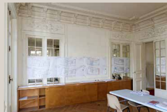
Vue d'un mur du salon à l'angle de la rue de la Huchette et de la place Saint-Michel, destiné à être démoli.
