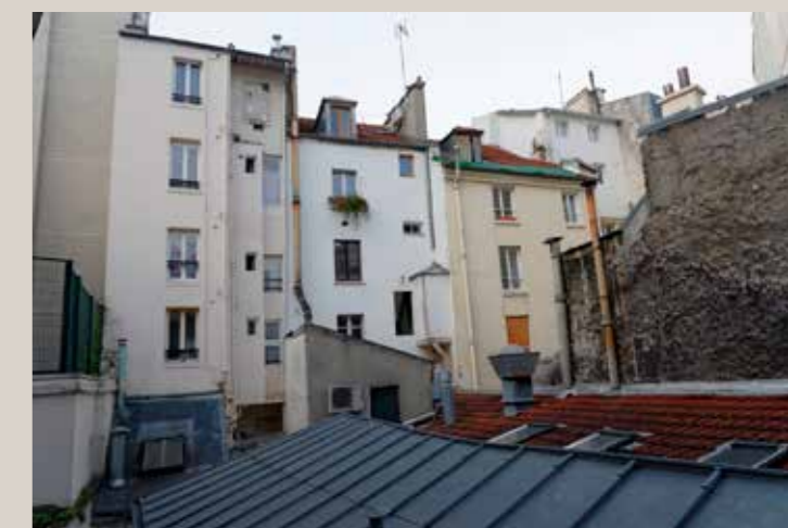
Vue actuelle de la façade sur cour.
