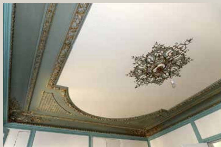
Plafond du salon néo-rocaïlle au deuxième étage.
