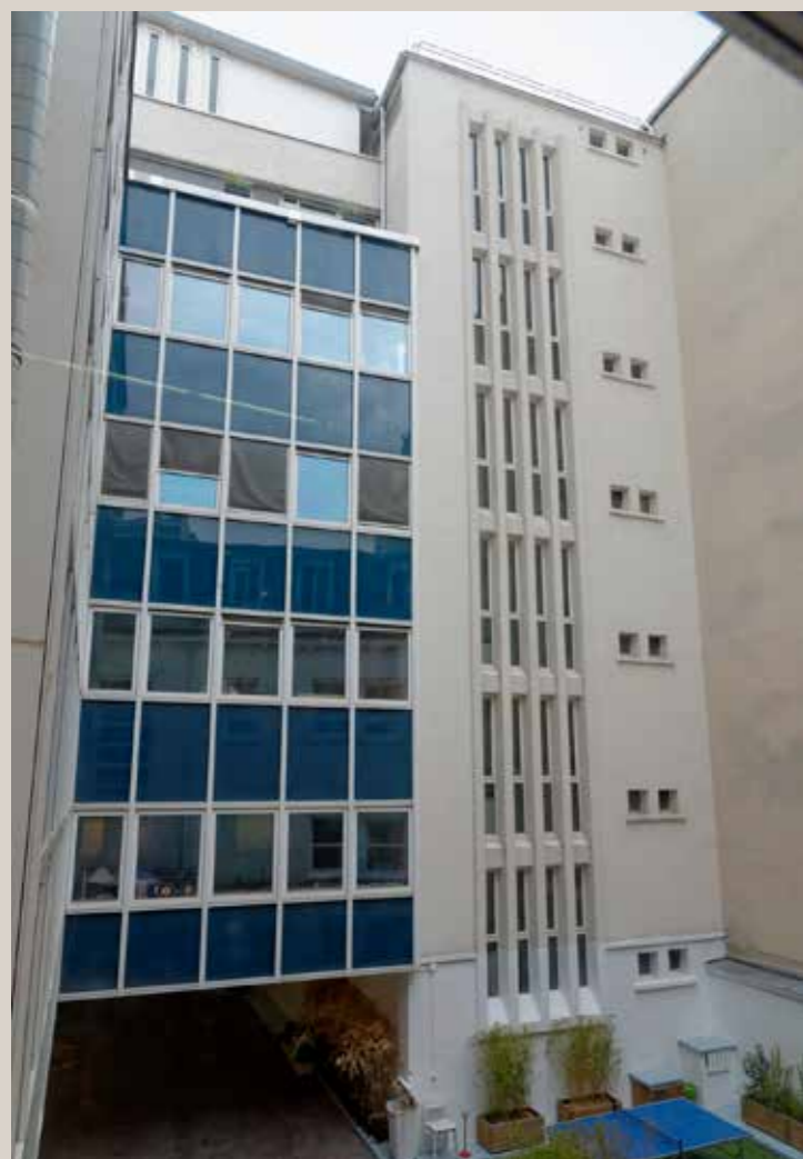
Vue actuelle de l'immeuble en fond de parcelle.
