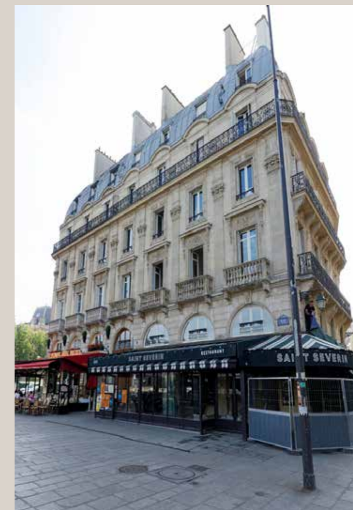
Vue actuelle de l'immeuble à l'angle de la place Saint-Michel et de la rue de la Huchette.
