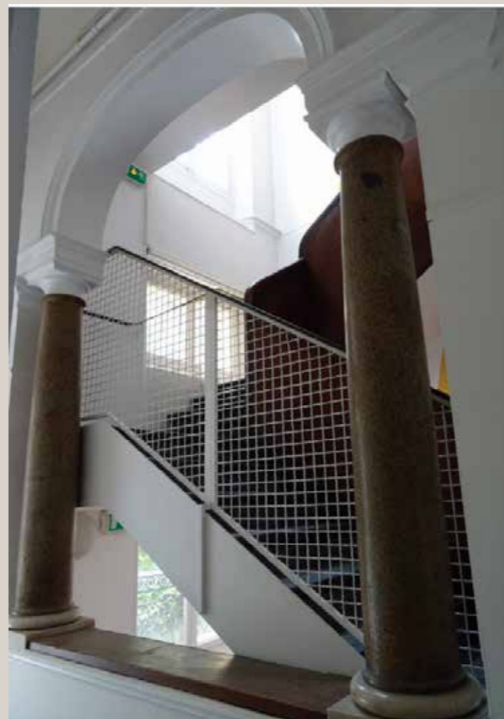
Ci-dessus : vue d'une baie serlienne ouvrant sur la cage d'escalier. Ci-contre : vue actuelle de la cour.
