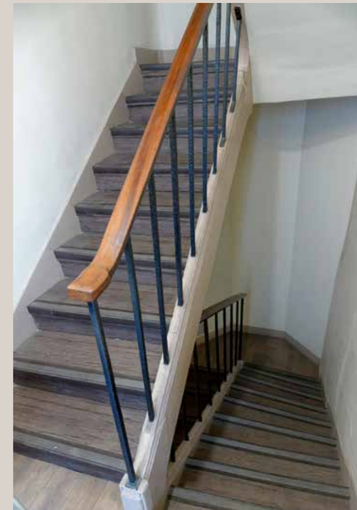
Vue actuelle de l'escalier.
