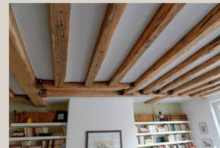
Vue actuelle des éléments de charpente conservés.
