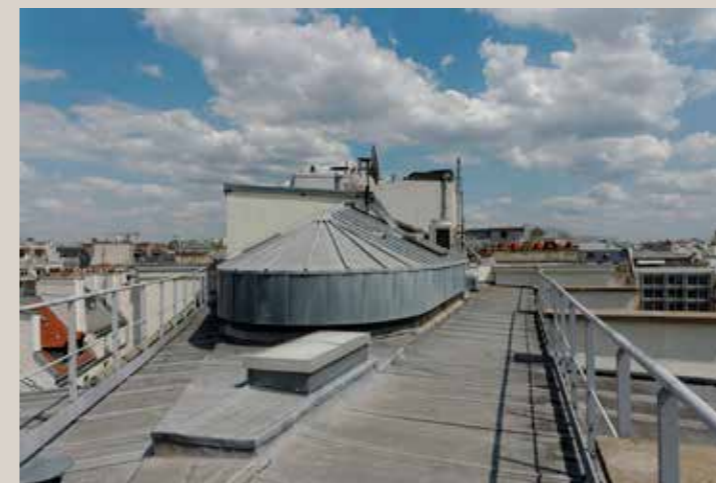
Vue actuelle de la toiture.
