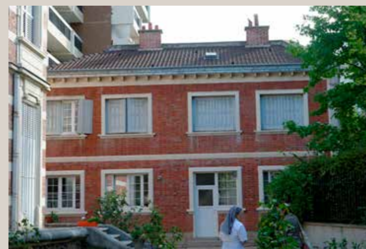
Vue du bâtiment en fond de cour, dont la surélévation est demandée.
