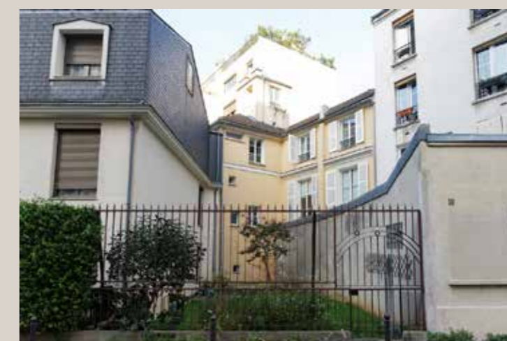
Vue actuelle de la façade arrière depuis le passage du Trône.
