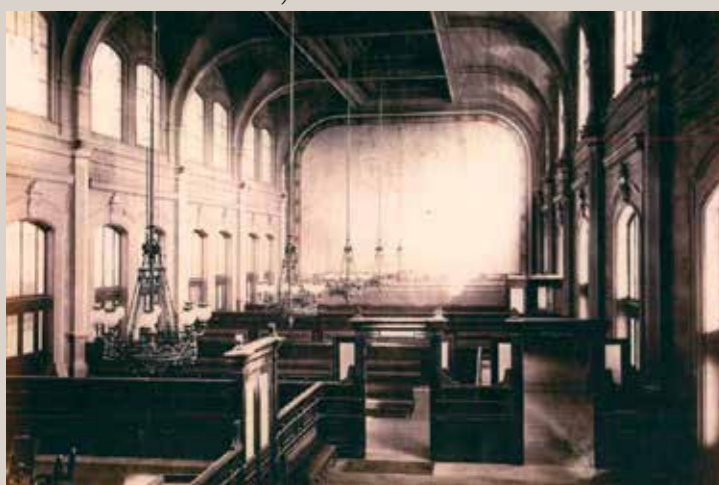
Vue intérieure de l'aile côté Seine au XIX e siècle (Archives Gare & Connexions de la SNCF).
