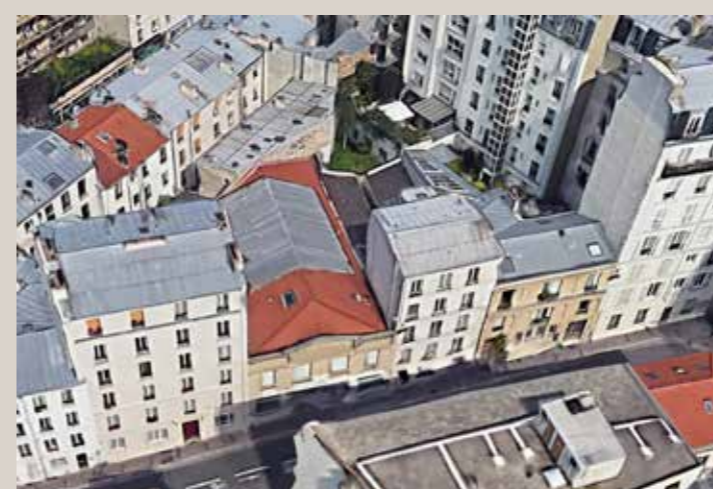
Vue aérienne de la parcelle (source : Internet).
