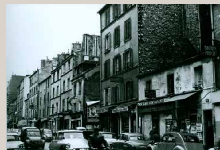
Vue de la rue de Reuilly, côté îlot Saint-Eloi, avant rénovation, 1961 (© Arsenal - Pauline Rossi).
