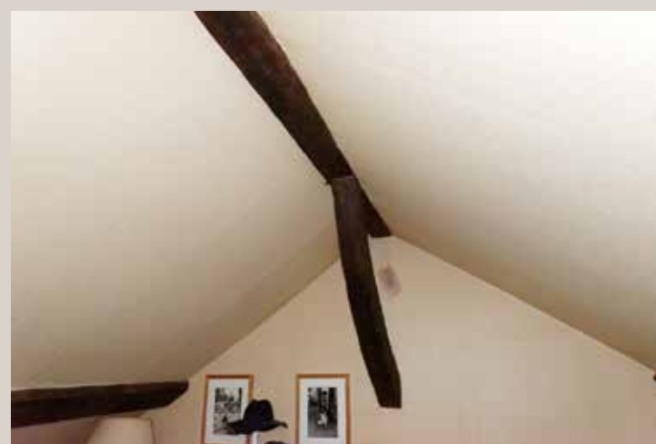
Vue de la charpente en place.
