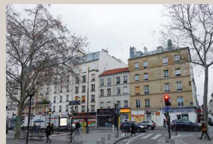
Vue actuelle de la séquence dans laquelle s'insère l'immeuble.
