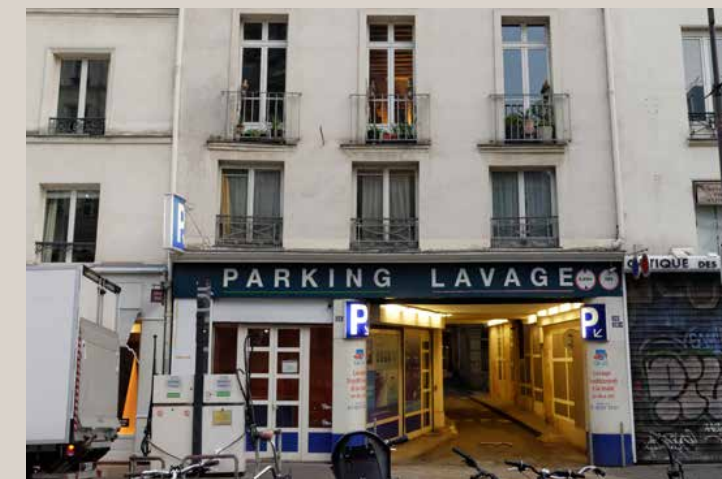
Vue actuelle de l'entrée de la parcelle depuis la rue Saint-Antoine.
