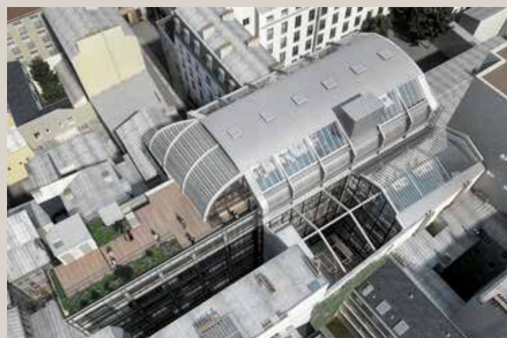
Vue aérienne, après restructuration de l'ancien garage parking (© B. architecture).
