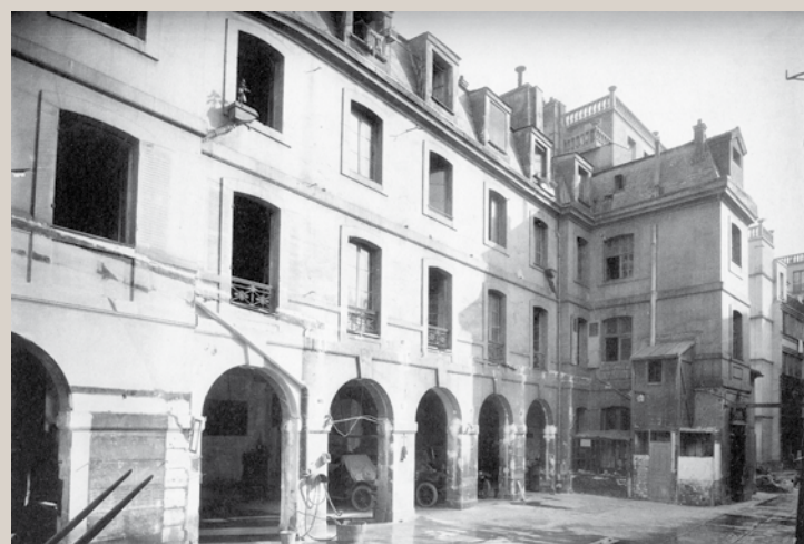
Vue de l'aile de l'ancien couvent des Filles de la Croix démolie en 1913 (© D.H.A.A.P.)
