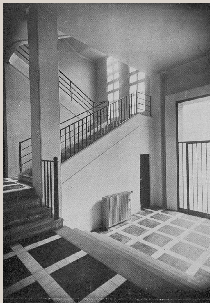
Vue du hall et de l'escalier (publiée dans La Construction moderne , 1934).
