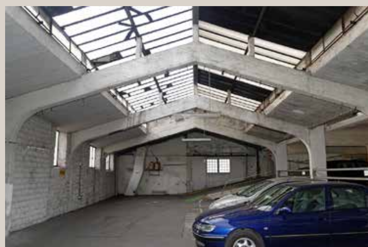
Vue actuelle du dernier étage de la partie droite du parking et de sa charpente en béton coiffée d'une verrière.
