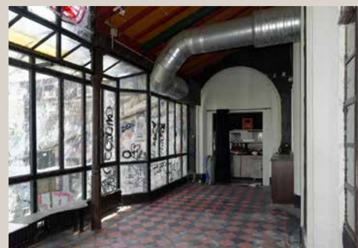
Vue actuelle de la verrière située à l'arrière du bâtiment principal.
