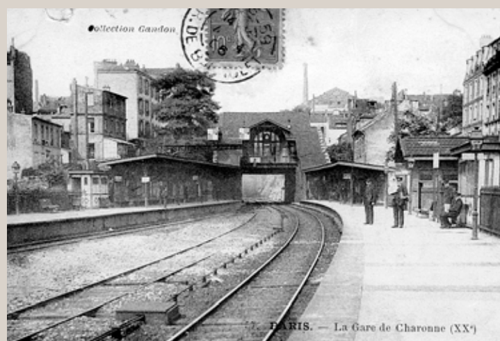
Vue ancienne de la gare de Charonne et des quais (source : Internet).
