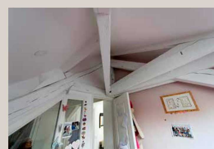
Vue de la charpente de la croupe biaise.
