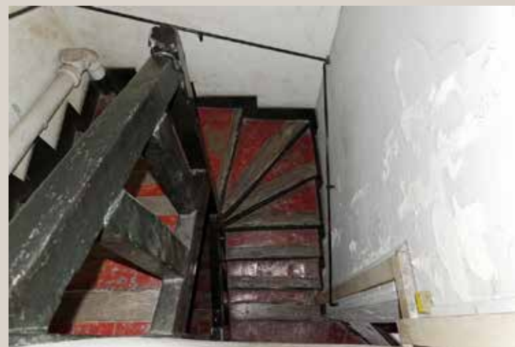
Vue d'une volée de l'escalier en bois à deux noyaux.
