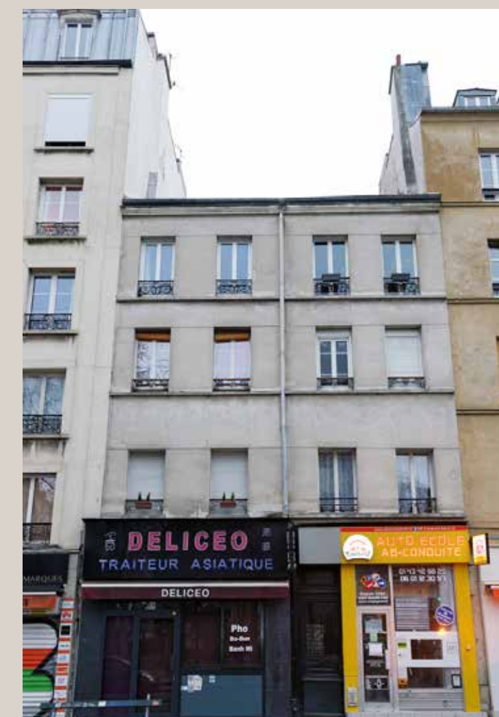
Vue actuelle de la façade principale sur la rue de Reuilly.
