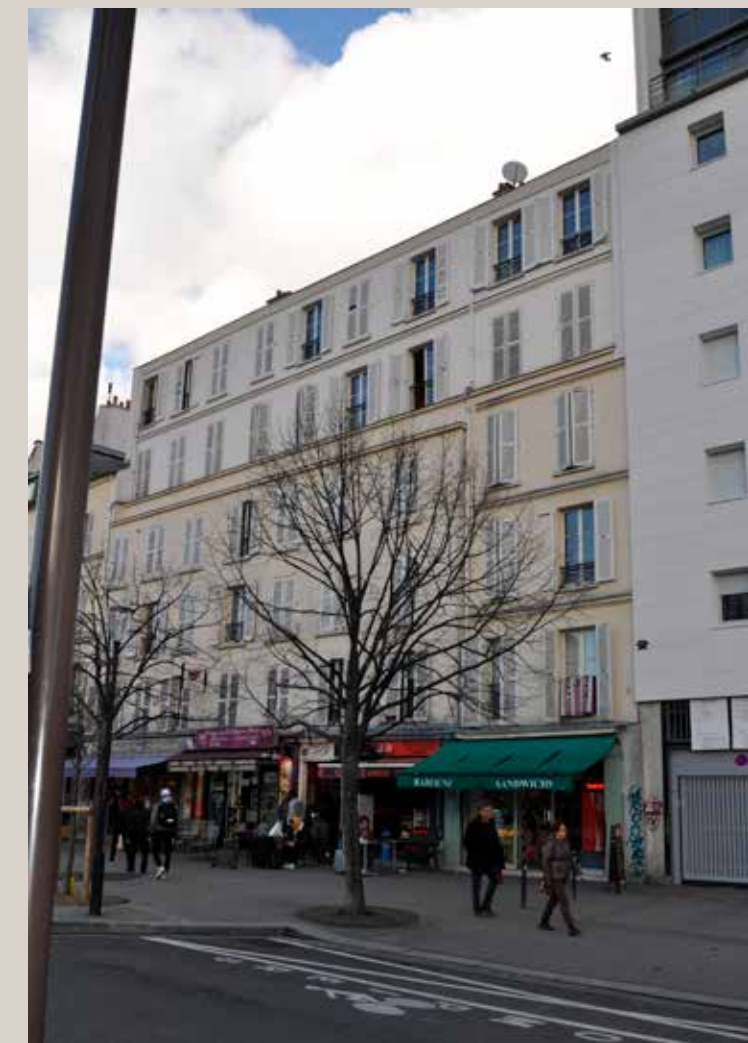
Vue actuelle de la façade principale du n° 116, depuis la rue.
