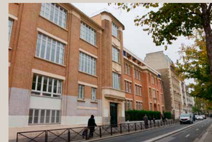
Vue actuelle de l'école. au premier plan l'extension, au fond le premier bâtiment.
