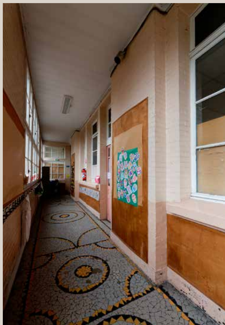
Vue actuelle du couloir qui dessert les différentes salles de classe au revers du premier bâtiment.
