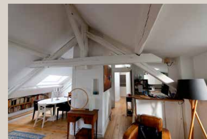
Vue actuelle de la charpente de l'immeuble.
