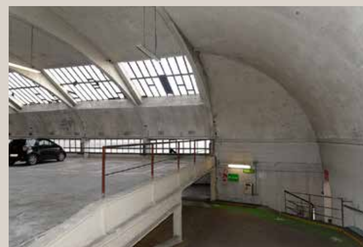
Vue actuelle du dernier niveau de la partie gauche du parking et de l'about de la voûte en abside.
