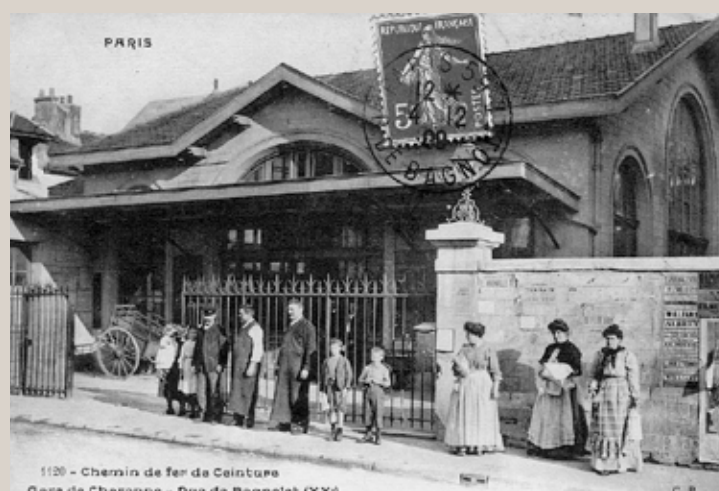
Vue ancienne de la gare de Charonne (source : Internet).
