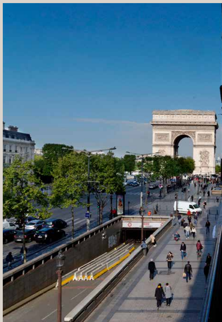
Vue d'une entrée de parking souterrain sur l'avenue des Champs-Élysées.
