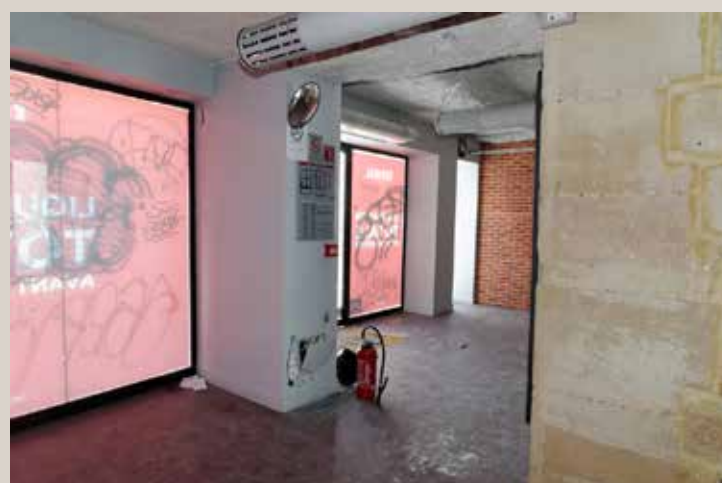
Vue actuelle de l'ouverture existante mettant en communication les deux parcelles.
