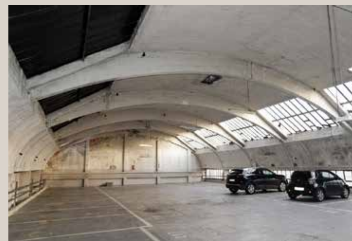
Vue actuelle du dernier niveau de la partie gauche du parking et de sa voûte en béton.
